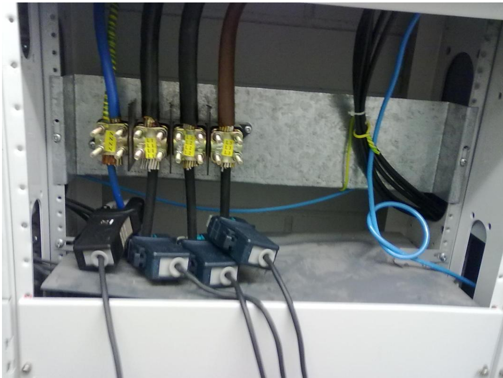
Kuva 2 Virtapihdit asetettiin jokaisen vaiheen ja nollajohtimen ympärille.
