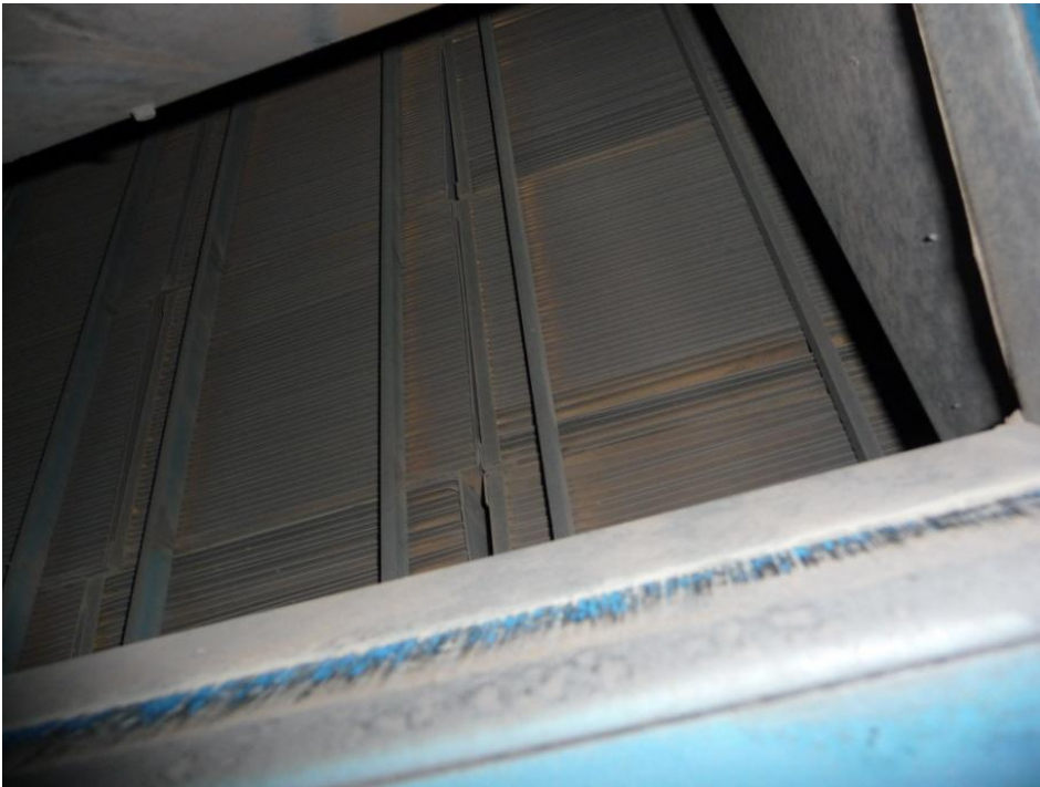
KUVA 5. 2TK1/2PK1-koneen lämmöntalteenottokennosto
