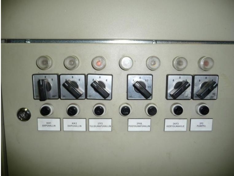
KUVA 7. 2TK2-koneen automaatiokytkimet
