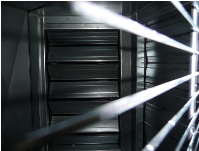
KUVA 6. LIK-16-koneen lämmöntalteenoton poistoilmapelti
