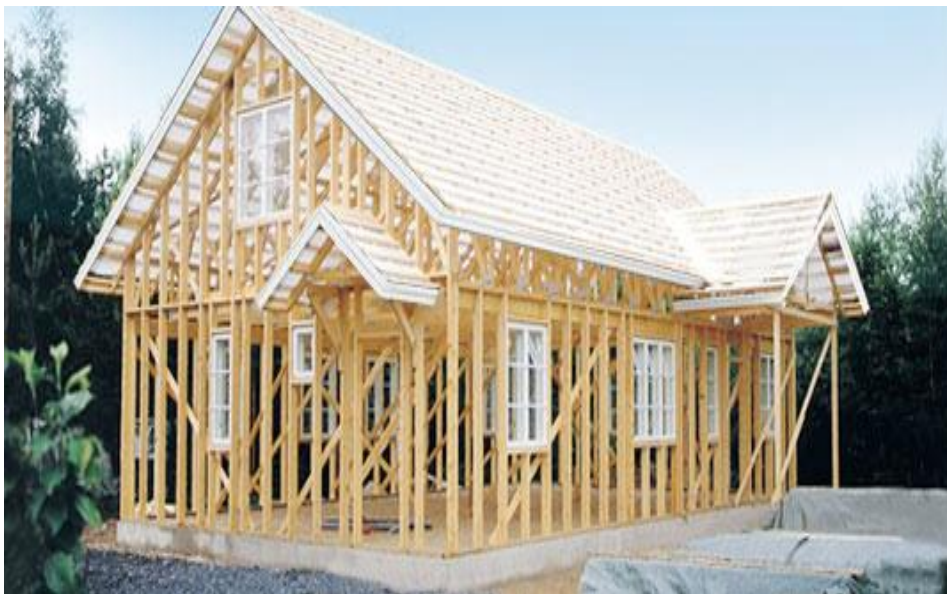
KUVA 3. Kastelli-talopaketti asennettuna sateelta suojaan (Kastelli-koti peruspaketti-toimituksena. 2011)
