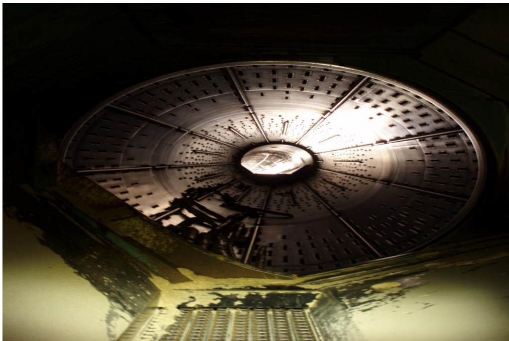
Kuva 3. Kaukopään kuorimon 1- linjan kuorimarumpu. 1-linjan kuorimarumpu on identtinen 3-linjan kuorimarummun kanssa. Kuvassa näkyy myös kuorimarummun kuorimaraudat, kuoriaukot ja purkauspään portti.
