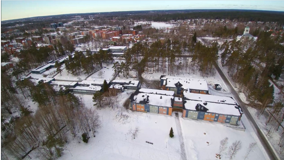
Kuva 6. Ilmakuva Helilän koulusta (kuva: Harri Sane).
