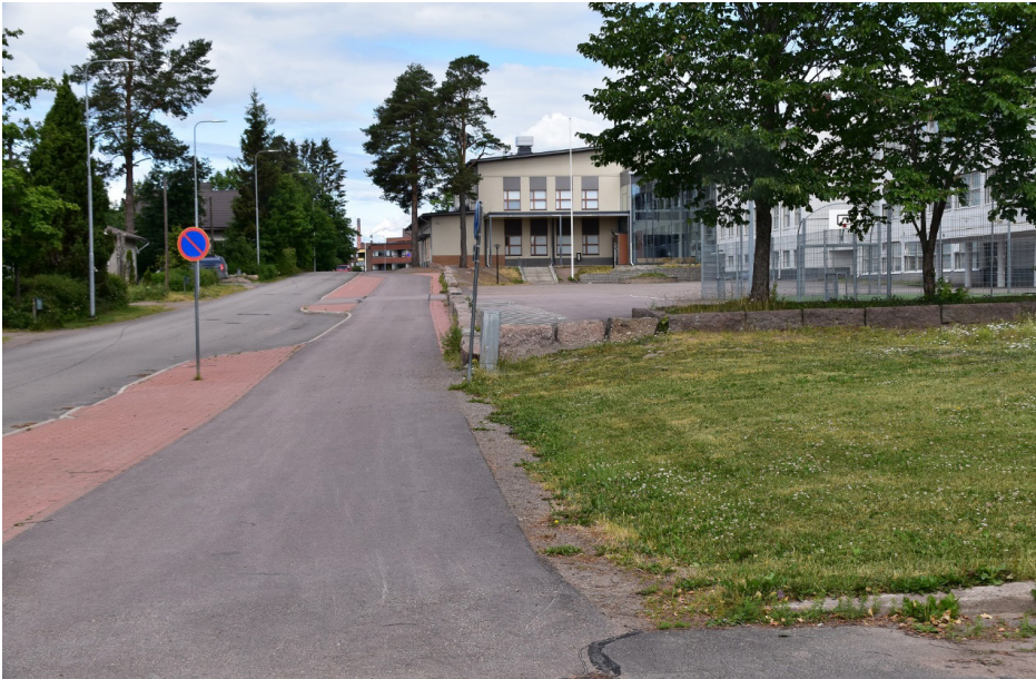
Kuva 11. Anjalan koulun väistötila Inkeröisissä (kuva: Jukka Hietapakka).
