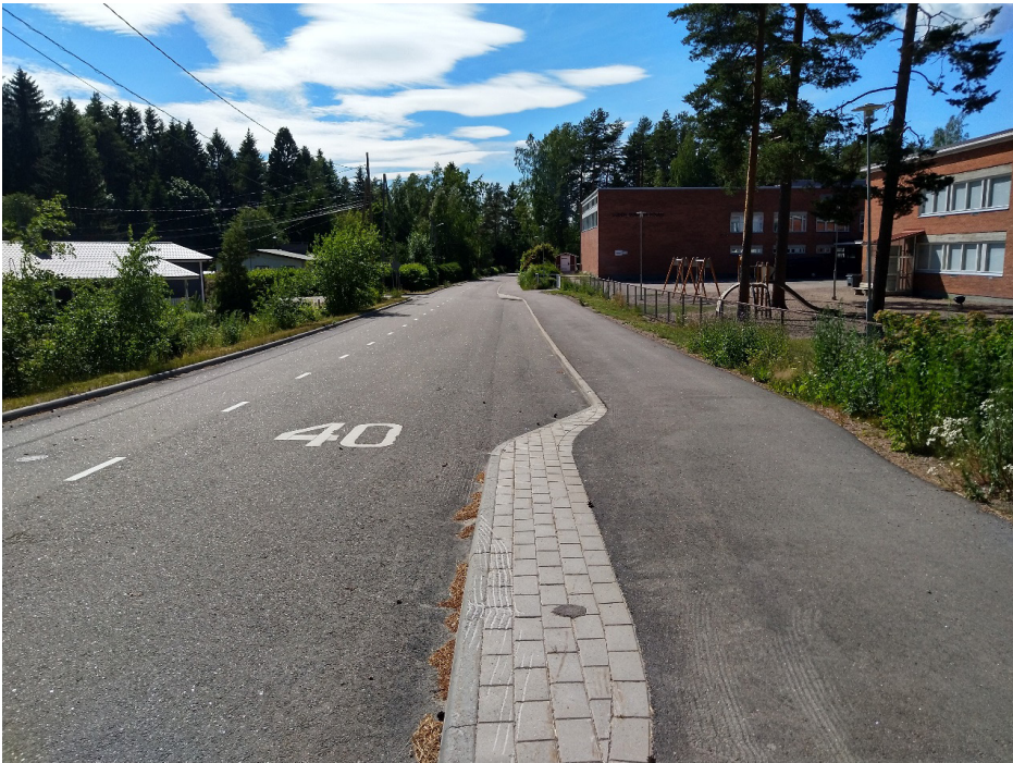
Kuva 1. Rakennettu levike saattoliikenteelle (kuva: Jukka Hietapakka).
