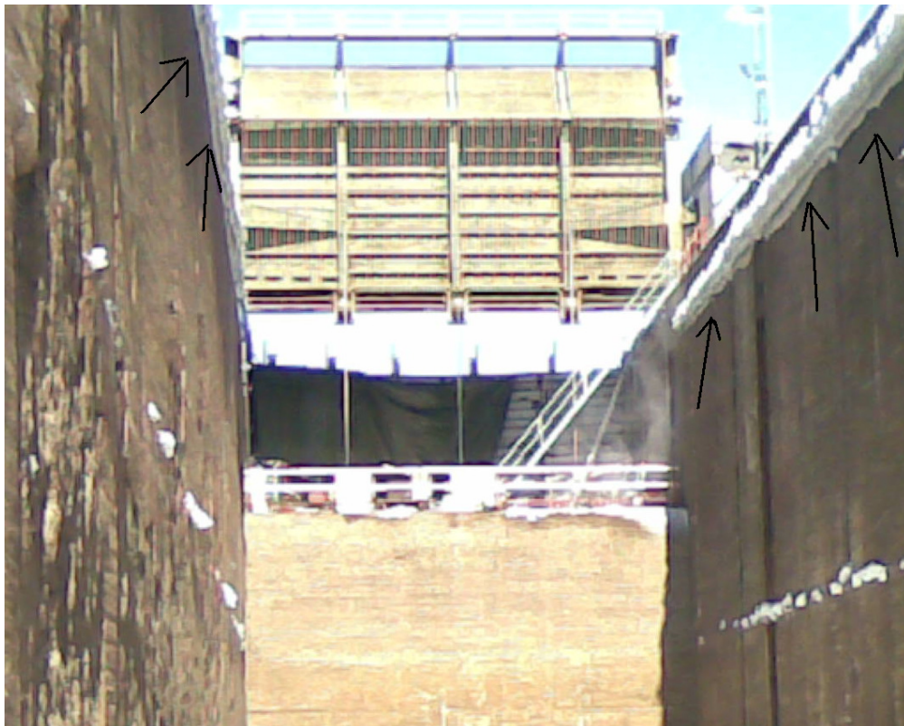
Kuva 15. Nuolet osoittavat sulun reunoille jäätyneitä jäävanoja.
