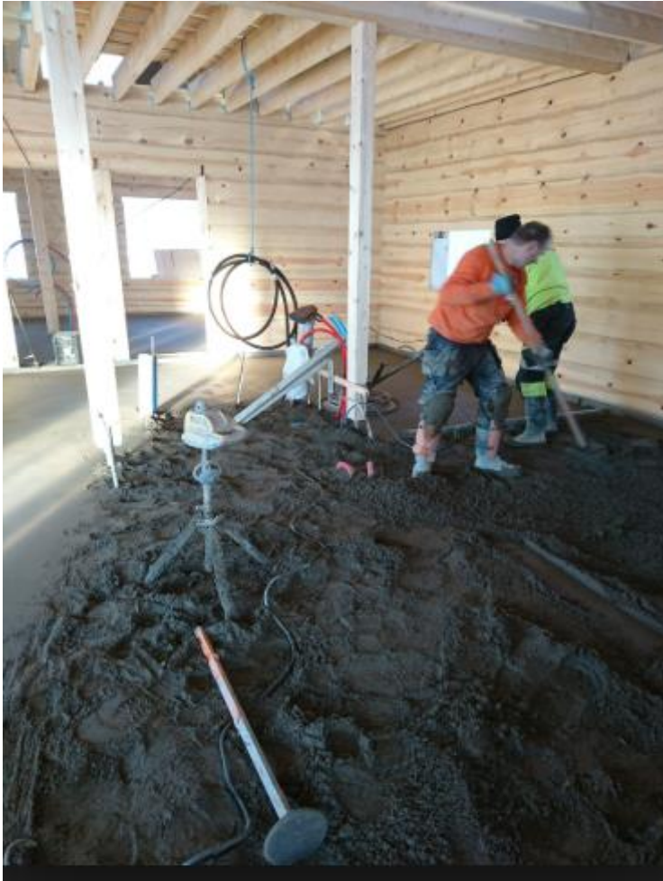
KUVA 10. Maakostean betonilattian työsty käynnissä. Kuvassa näkyy myös maasan tiivistykseen tarkoitettu sauva (25)
