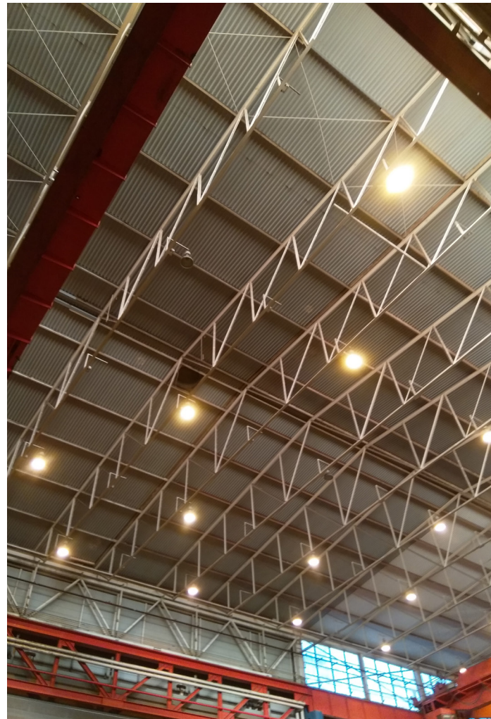
Kuva 15. 400 W suurpainenatriumvalaisimia korkean hallin katossa. Kuva: Teija Järvenpää, SAMK.
