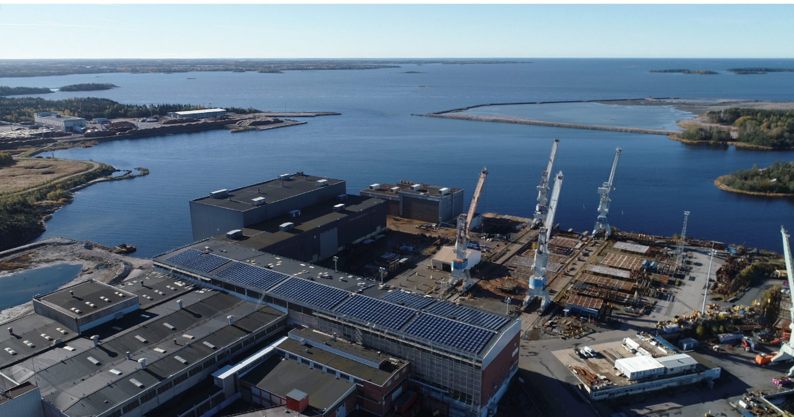
Kuva 13. Aurinkovoimala lohko-tehtaan katolla kuvattuna lokakuussa 2018, jolloin aurinkopaneeleista oli asennettu noin 2/3. Kuva: Kristiina Kortelainen, SAMK.
