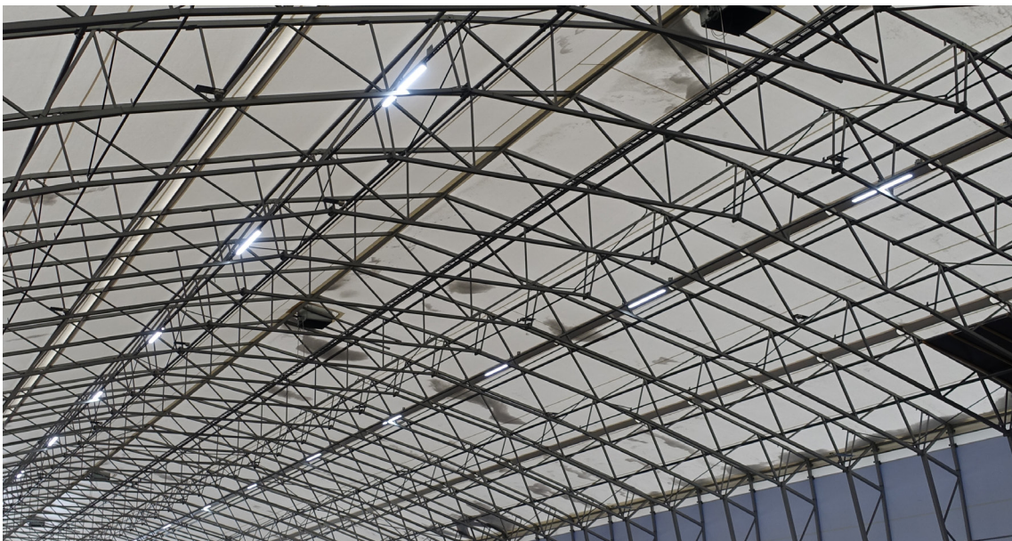
Kuva 29. Liiketunnistuksella toimiva led-valaistus Euroports Rauman varastohallissa. Kuva: Teemu Heikkinen, SAMK.
