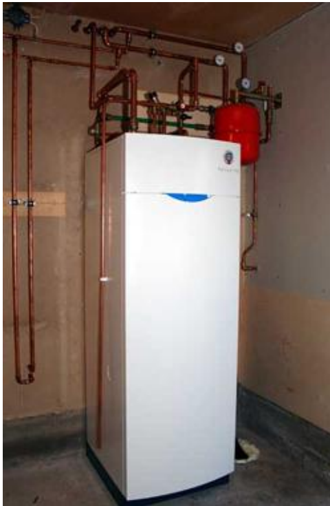
KUVIO 16. Maalämpöpumpun lämmönvaihdin. (Turunmaan Lämpöotalo Oy, 2010.)
