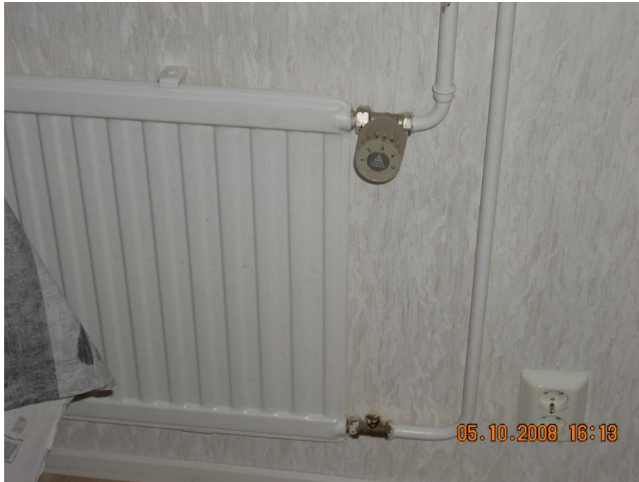
KUVIO 28. Patterin säätötermostaatti.
