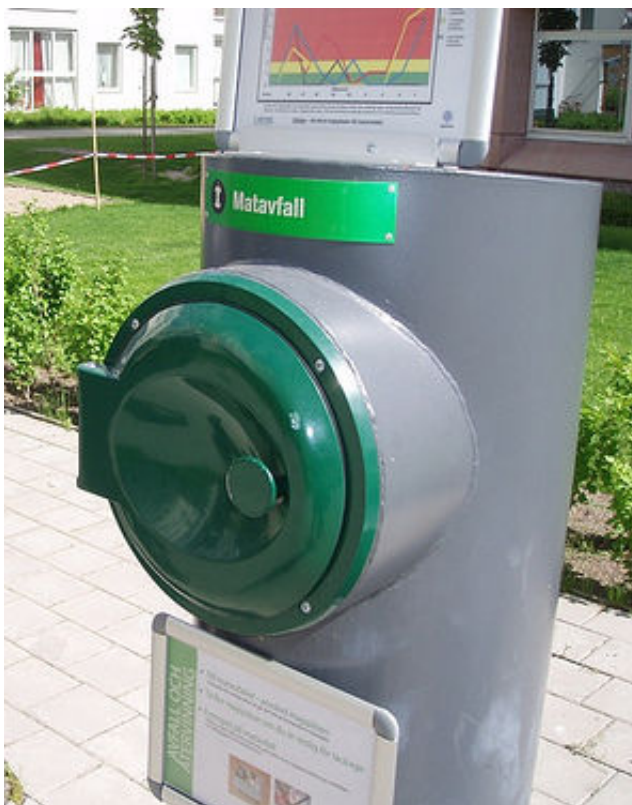
Kuva 3. Envac AB:n pudotuskuilutyypinen keräilyterminaali
