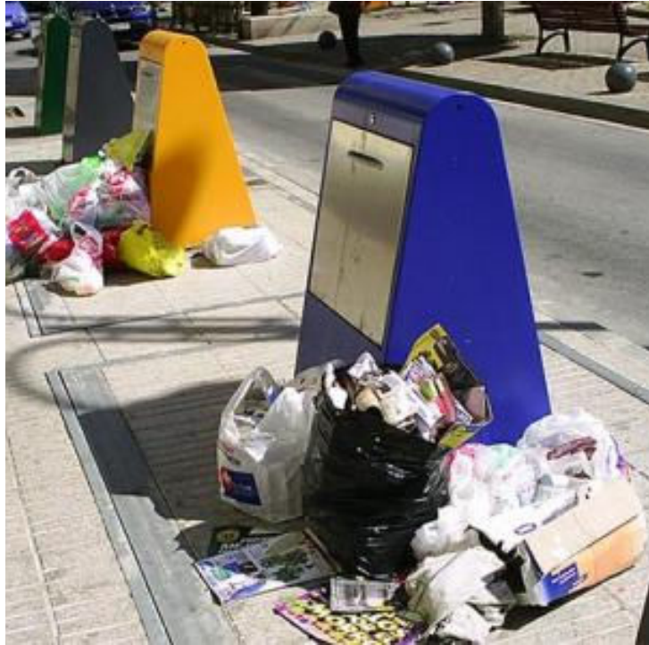
Kuva 9. Käyttökatkos pudotuskuilumallisessa keräilyterminaalissa
