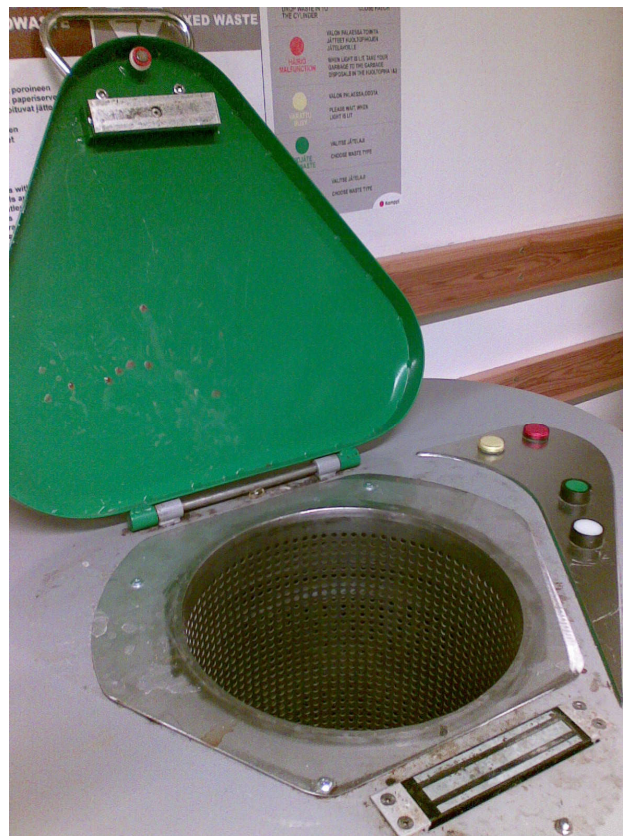
Kuva 18. Ecosir Oy:n terminaalin pudotuskuilu.
