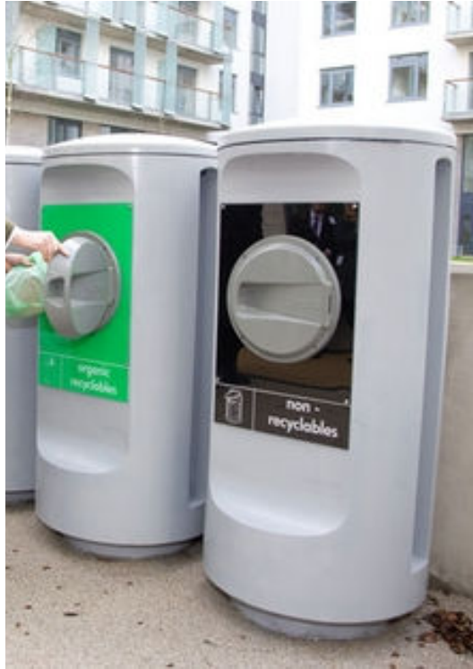
Kuva 7. Envac AB:n pudotuskuiluterminaali korvausilmakuorilla
