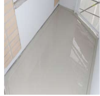
Kuva 7: Parvekkeen lattia maalattu PUR-pohjaisella maalilla (Tikkurila Oy.)
