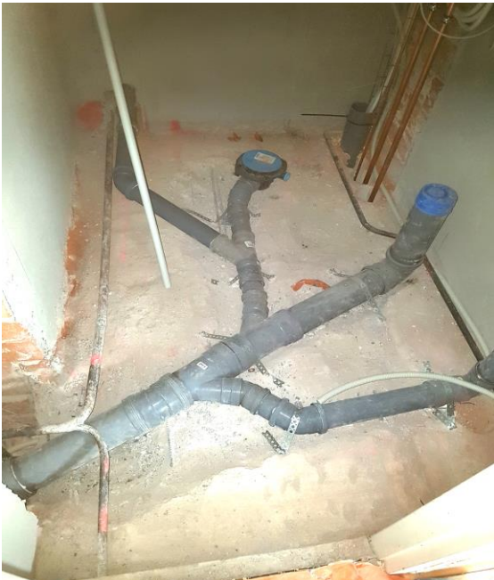
Kuva 1. Muoviset viemäriputket asennettuina kiinteästi lattiaan, hajotukset on yhdistetty pystyviemäriin. Seinän läpi menevä viemäri on viety seinän läpi keittiön pesualtaalle.
