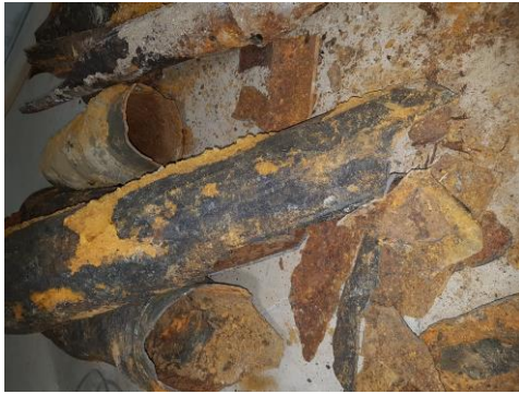
Kuva 5. Kuva otettiin silloin, kun rakennusmiehet ovat piikanneet noin yhden päivän vanhoja valurautoja pois betonista.
