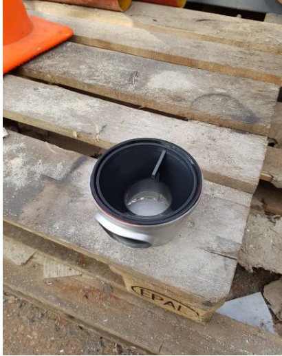
Kuva 7. Kuvassa on insertti, uudenlainen ruostumattomasta teräksestä valmistettu lattiakaivo.
