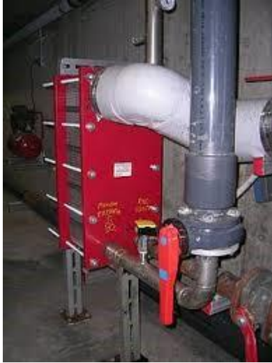
Kuva 11. Uimahallin lämmönsiirrin.
