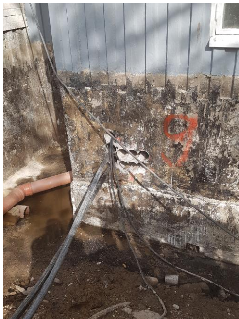
Kuva 19. Kuvassa on kaivanto, jossa tuodaan talonseinän läpi syöttökaapeleita.
