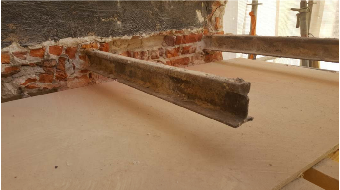
Kuva 34. Ratakiskot puhdistetaan ja suojataan korroosionestolaastilla.
