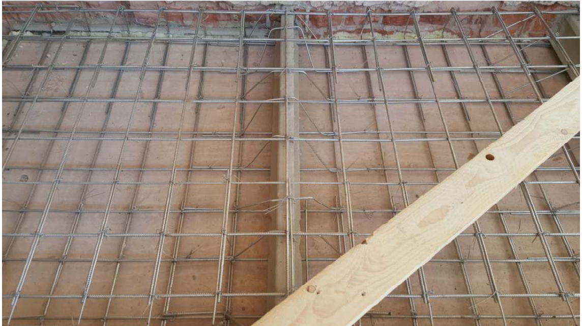
Kuva 35. Ratakiskot on suojattu korroosionestolaastilla, suunnitelmien mukaisten raudoitteiden asennustyöt ovat käynnissä.
