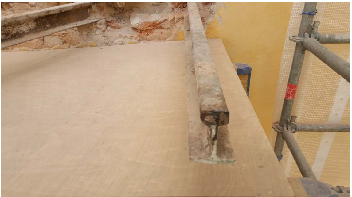
Kuva 33. Ratakiskot puhdistetaan ja suojataan korroosionestolaastilla.
