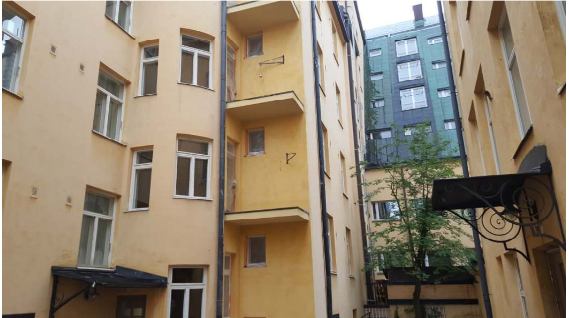
Kuva 40. Parvekelaatat on valettu ja muotit poistettu. Liittyvien seinäpintojen paikka- ja maalaustyöt on tehty.
