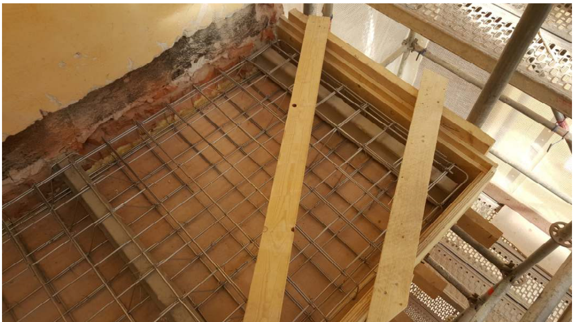
Kuva 36. Ratakiskot on suojattu korroosionestolaastilla, suunnitelmien mukaisten raudoitteiden asennustyöt ovat käynnissä.
