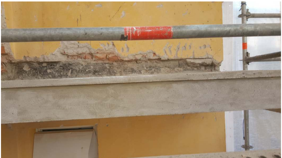
Kuva 37. Parvekelaatat on valettu ja muotit poistettu.
