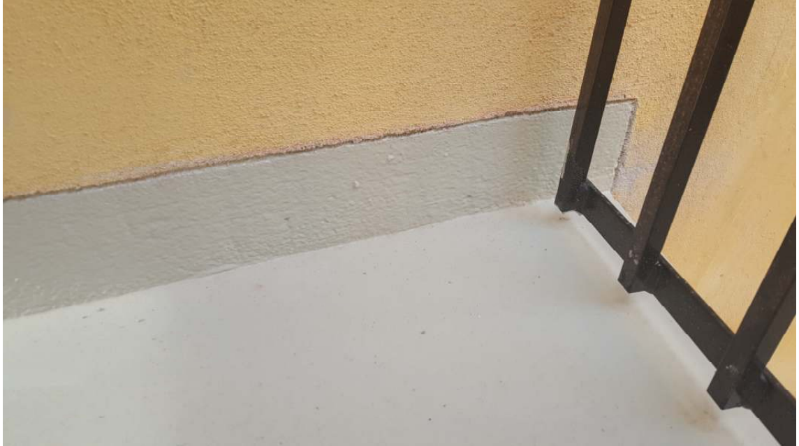
Kuva 42. Parvekkeet valmiina. Vedeneristeenä toimiva pinnoite on nostettu siististi seinälle, seinän rappauksen ja ”jalkalistan” rajalle tehtiin ns. v-ura jotta rajakohdasta saatiin siisti.
