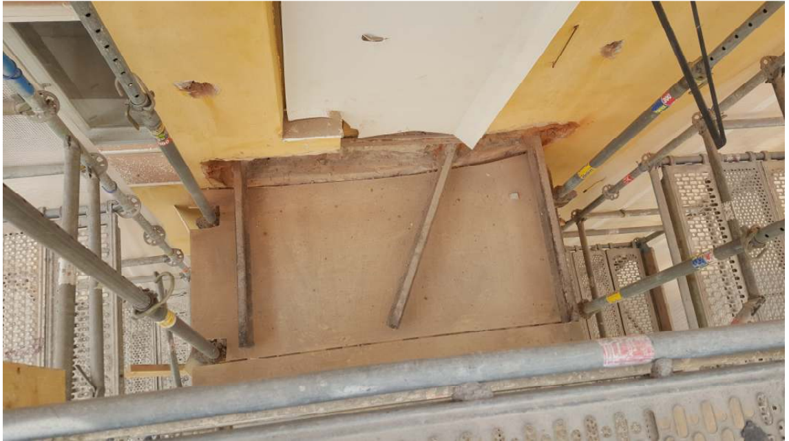
Kuva 32. Vanhat parvekelaatat on purettu pois. Ennen purkutöitä muotin pohja rakennettiin valmiiksi vanhan parvekelaatan kokoisena, muotin pohja toimii samalla purkutöiden alustana estäen purkujätteen putoamisen alas.
