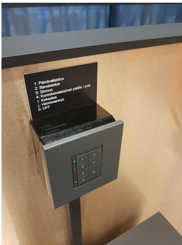
Kuva 8. Ohjauspaneeli ja muovinen kaiverrettu merkintäkilpi toiminteista.
