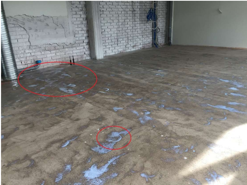
Kuva 4. Syviä, puolipyöreitä uria lattiasa kuppilaikkahionnan jäljiltä
