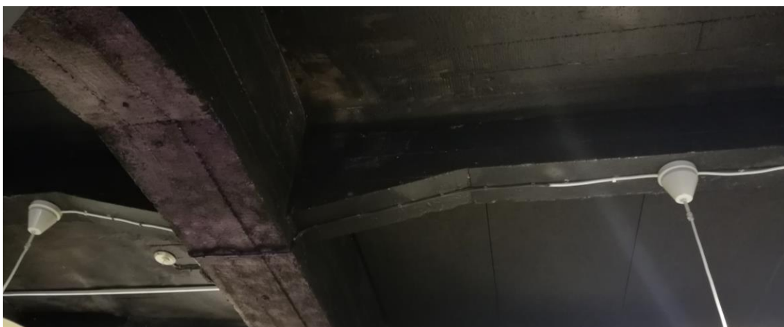
Kuva 14 Välipohjarakenne Auttilankulmassa (kuva: Anniina Grönholm)
