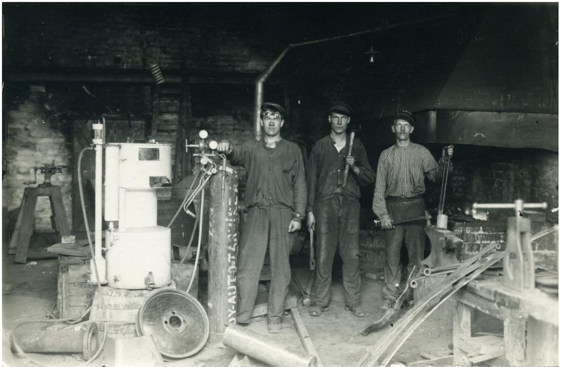
Kuva 7 Autokorjaamon paja Auttilankulmassa vuonna 1928 (kuva: Rasmussen, N., valokuvaamo, Tampere, Työväenmuseo Werstas)
