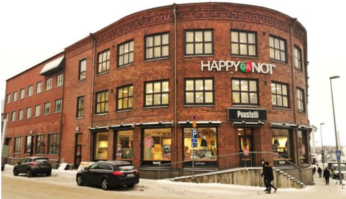
Kuva 3 Koy Auttilankulma Sorinkadun ja Vuolteenkadun risteys. Kuva: Anniina Grönholm
