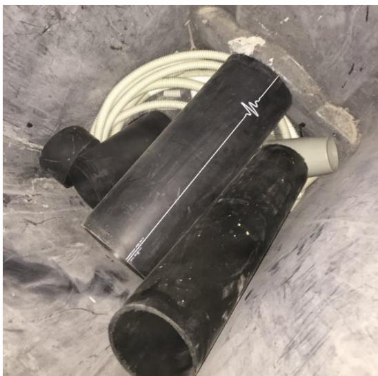
Kuva 6. Muoviputkia PVC-jäteastiassa (Kuva: Pessi Suonpää).
