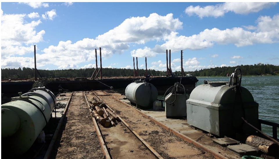
Kuva 7. Nippula toimii siltana proomuun, kun sitä lastataan.
