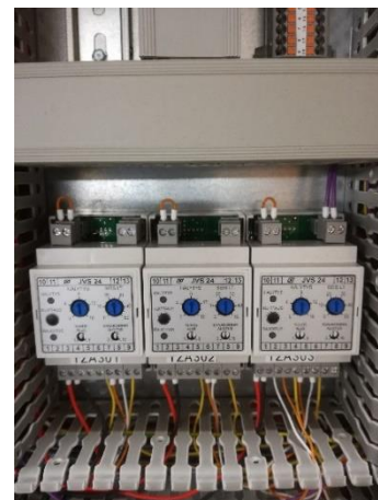
Kuva 12. Jäätymisvaaratermostaatti
