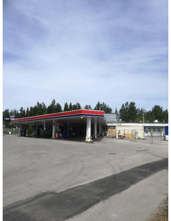
Kuva 2. Projektin työkohde. Teboil Kaivoxela
