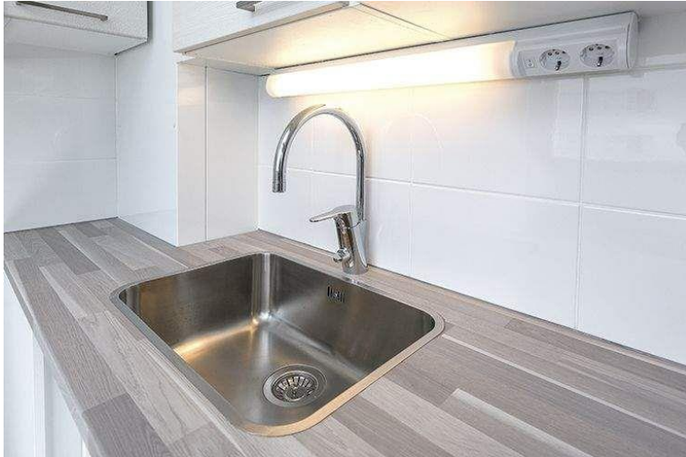
Kuva 11. Keittiöön sijoitettu kotelointi Pipe-Modul -moduuliratkaisulla (Pipe-Modul Oy)
