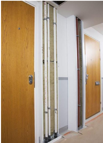
Kuva 9. Pipe-Modul-moduuliratkaisu ennen kotelon sulkemista (Pipe-Modul Oy)
