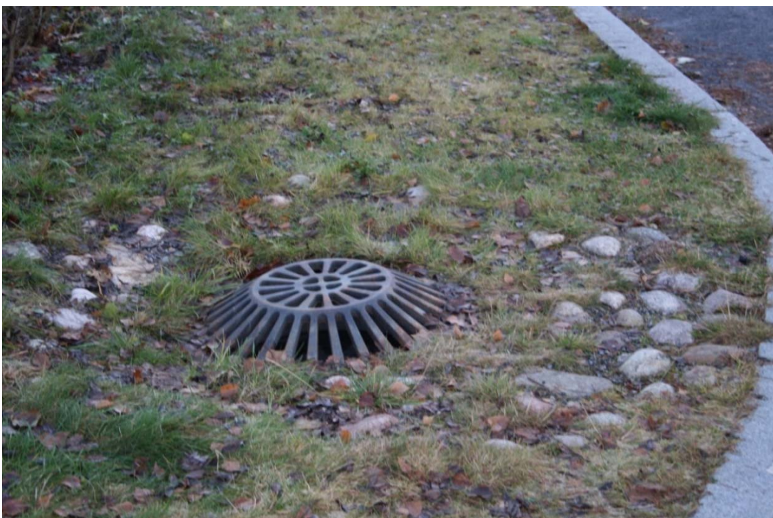
Kuva 8. Kaivojen ympärykset (Åkerfelt 2017).
