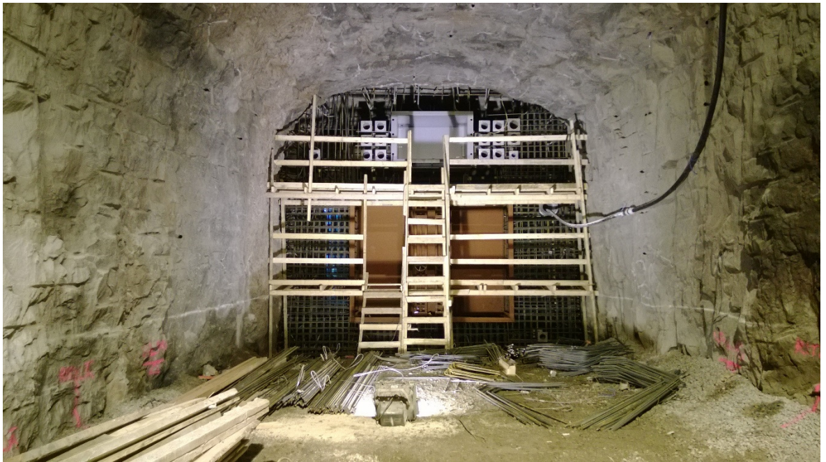
Kuva 12. VSS-rakenteiden raudoitusta
