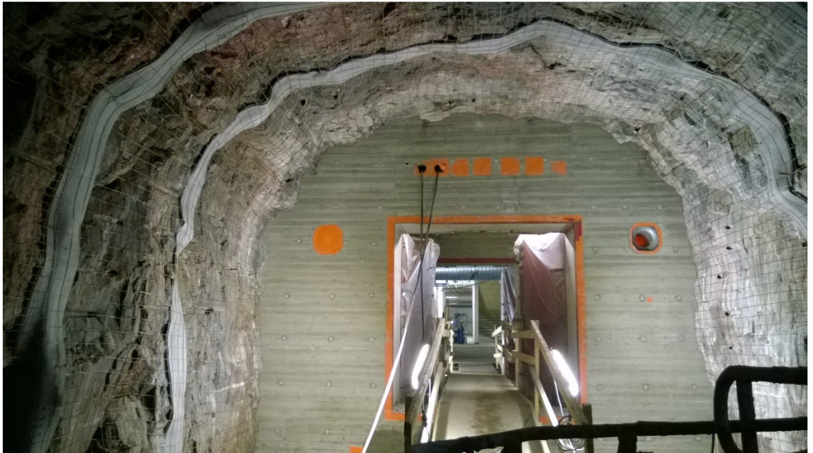
Kuva 7. Kalliopinta salaojitettu ja verkotettu ruiskubetonointia varten
