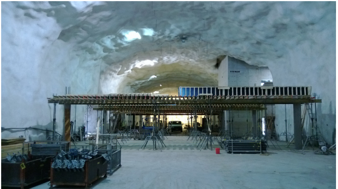
Kuva 11. Pysäköintihallin holvimuottityö käynnissä
