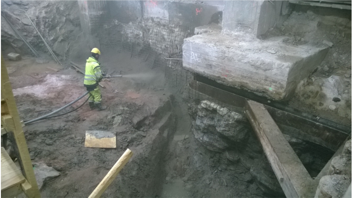
Kuva 4. Kallion lujitusta sekä pulttaamalla että ruiskubetonoimalla
