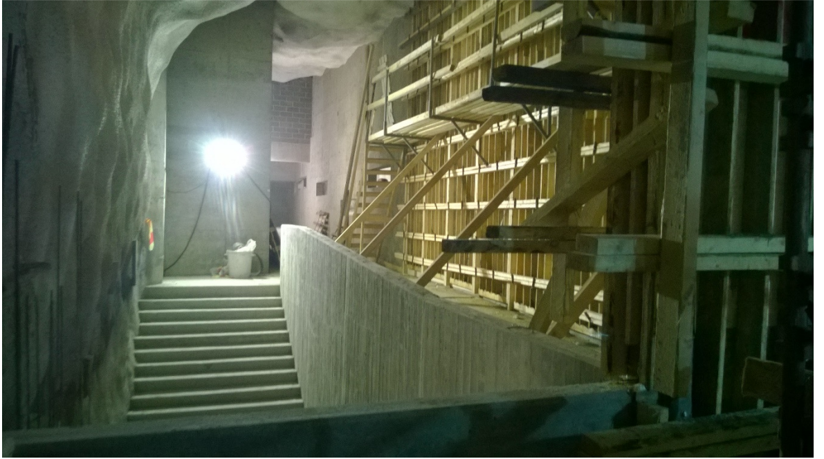
Kuva 9. Seinämuotti kappaletavarasta
