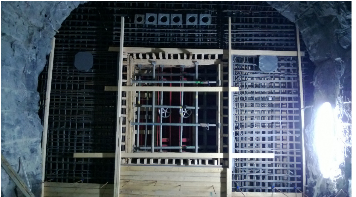
Kuva 10. VSS-rakenteen raudoitus on valmis ja laudoitus aloitettu
