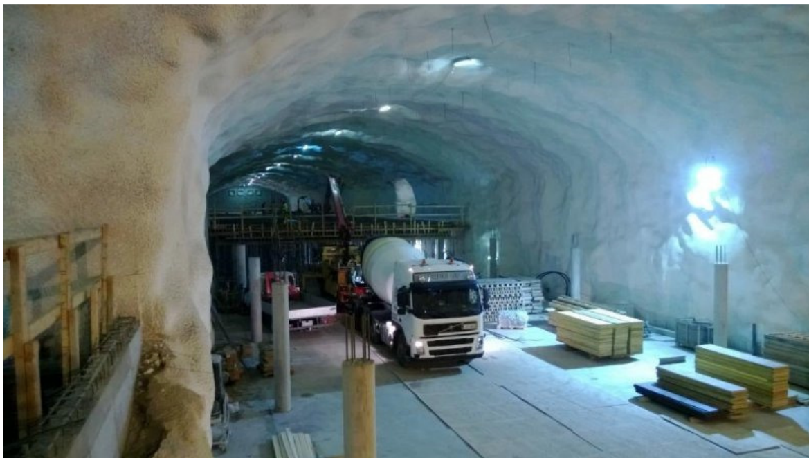
Kuva 16. Holvin valu käynnissä
