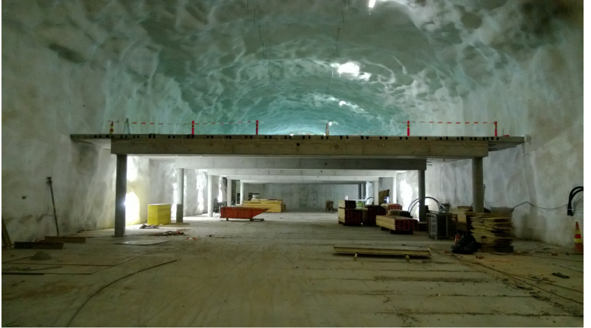
Kuva 14. Pysäköintihallin jälkijännitettyä holvia
