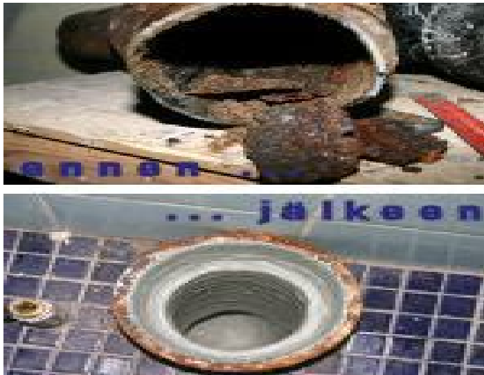
KUVA 9. Ennen ja jälkeen pinnoituksen (Ew-liner 2010.)
