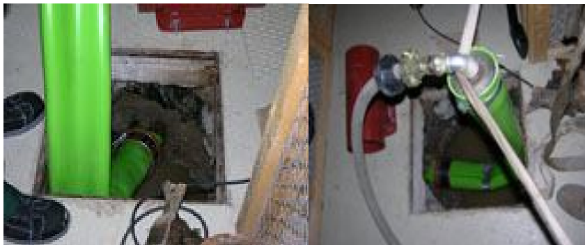
KUVA 8. Sujutusputken asennus (Nrgroup 2010.)
