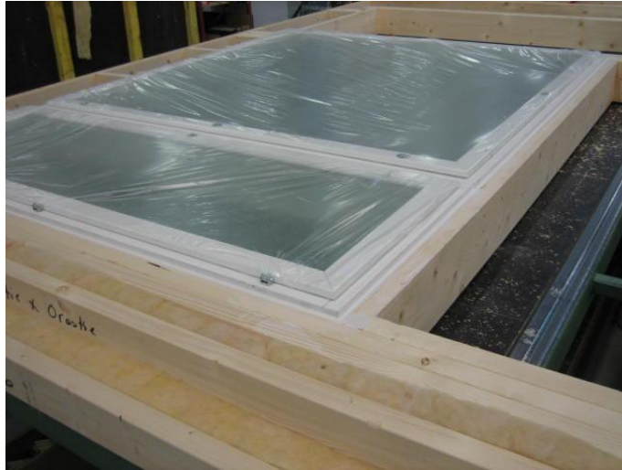
KUVIO 3. Ikkunoiden asentamista elementtitehtaalla. (Laitala 2010.)
