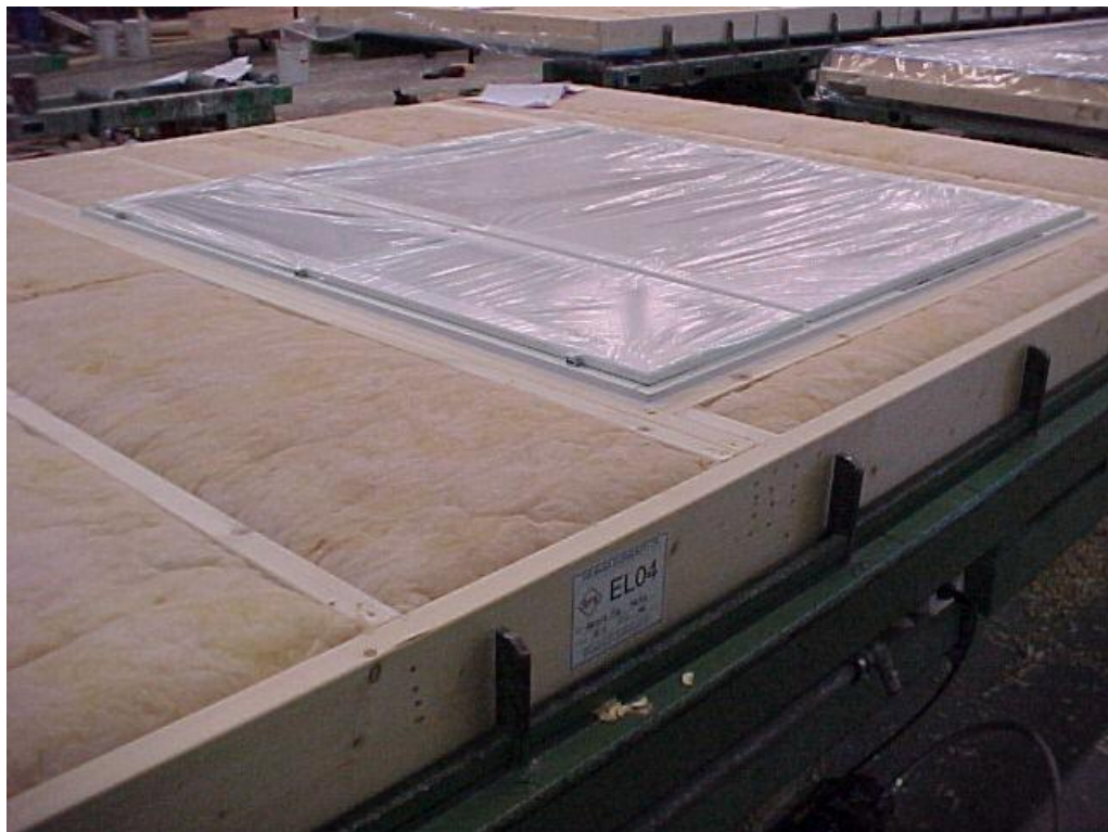
KUVIO 4. Ikkuna asennettuna elementtitehtaalla. (Laitala 2010.)
