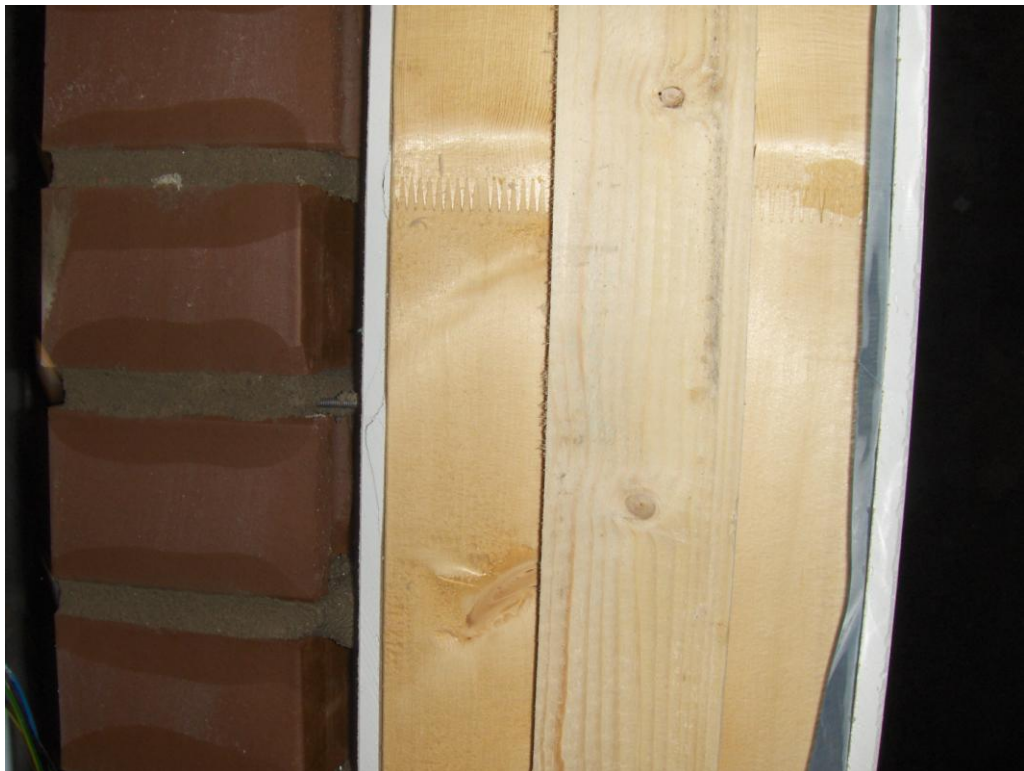
KUVIO 5. Puu-ulkoseinäelementti asennettuna ja johon on julkisivutiilet elementin asennuksen jälkeen muurattuna. (Hiipakka 2010.)
