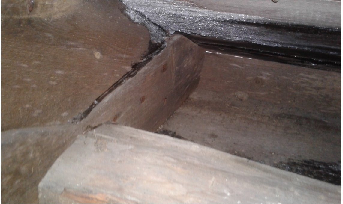
Kuvio 5. Rästäs rakenne ja sen vaurioita
