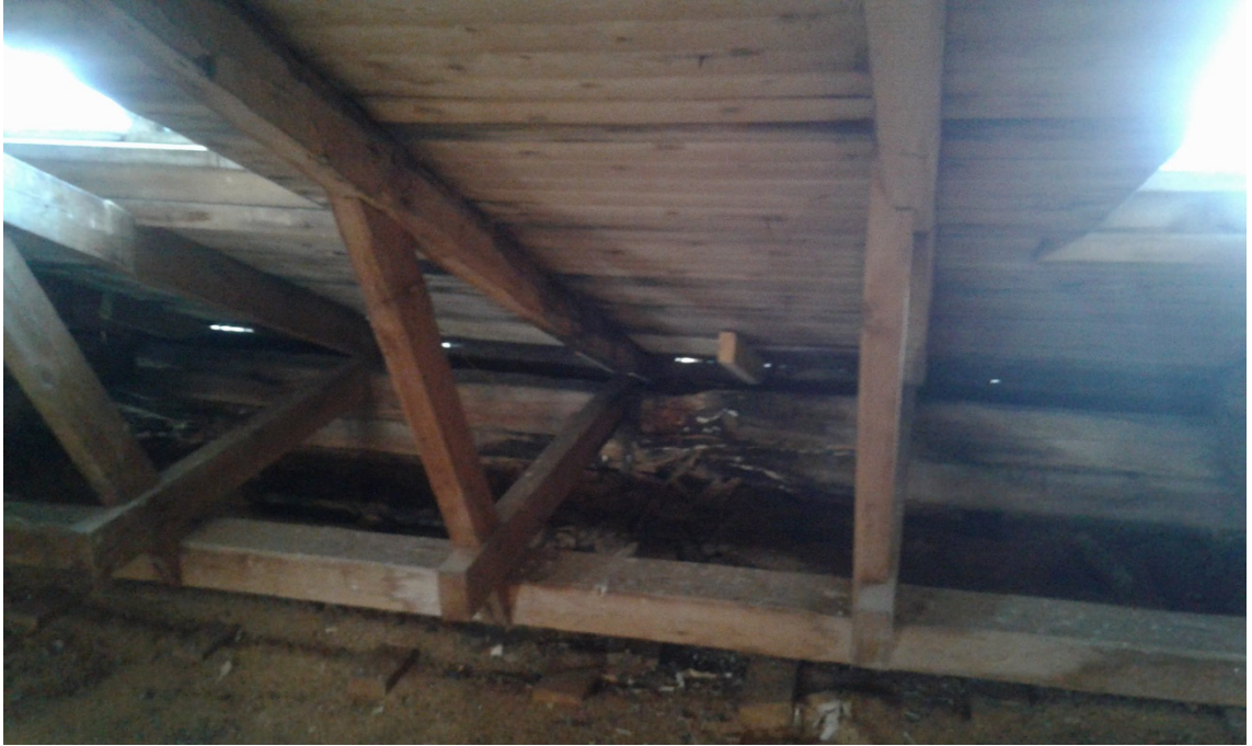
Kuvio 2. Hirsirungon kosteusvaurio
