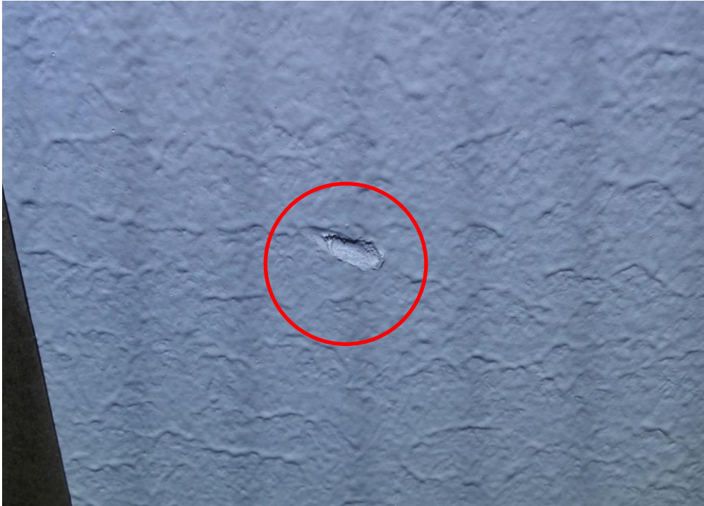
Kuva 14 Valmiiseen seinäpintaan jälkepäin syntynyt kolhu
