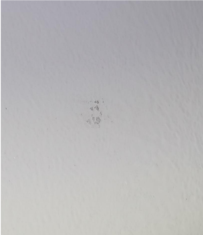
Kuva 13 Valmiissa seinä pinnassa jälki
