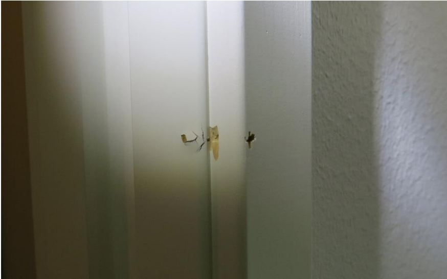
Kuva 12 Esimerkkikuva listasta, josta on lohjennut palanen kiinnitysvaiheessa
