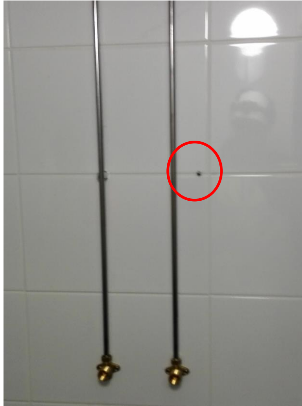
Kuva 17 Vesiputkien kiinnike porattu väärään kohtaan.
