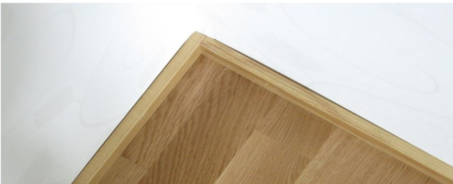
Kuva 11 Esimerkkikuva seinän ja listan välisestä raosta
