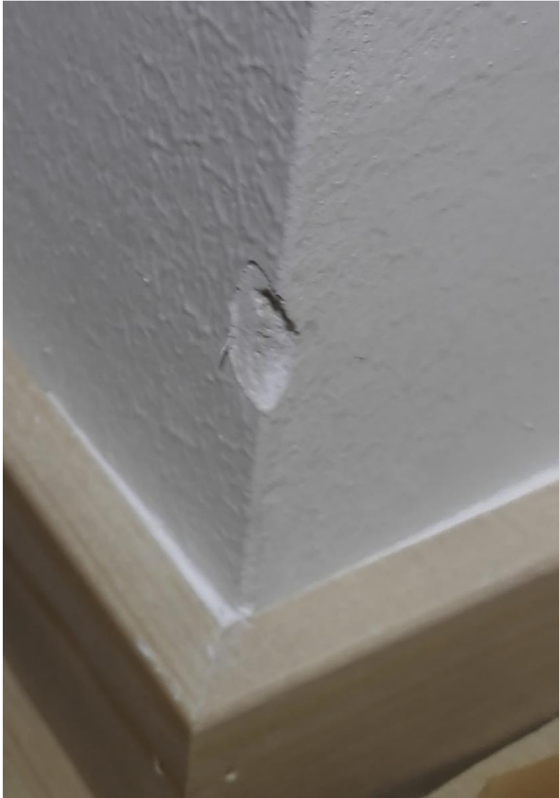
Kuva 19 Seinän ulkonurkka kolhiintunut
