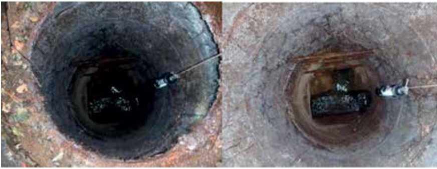
Kuva 4. Oikealla näkyvät betonikaivon yläosan jäätyneet renkaat. Vasemmanpuoleisessa kuvassa näkyy saman kaivon pohja ja kaivoon tunkeutuneet hiusjuuret (kuva Ramboll Oy).
