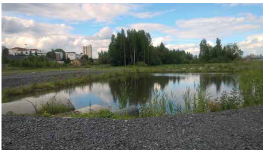
Kuva 1. Veturitallinlahden rakennettu viivästysallas Mikkelissä (kuva Riina Tuominen).
