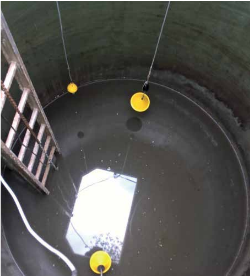
Kuva 2. YSI-sondi paikalleen asennettuna kettingin päässä täysin veteen upotettuna pumppaamokaivossa (kuva Riina Tuominen).
