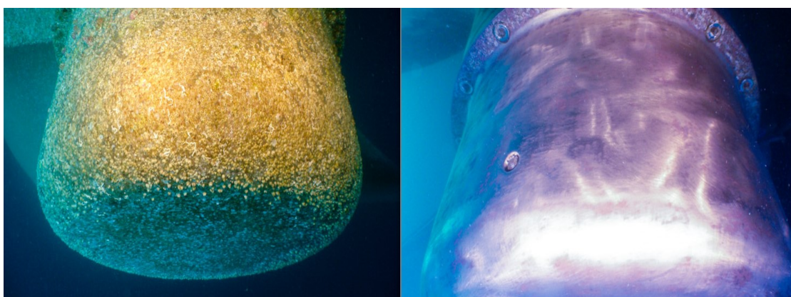
Kuva 11. Tilanne ennen ja jälkeen kiillotuksen (Commercial diving services 2013).
