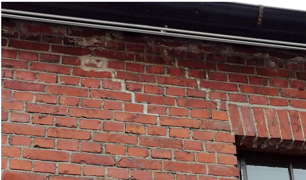
Kuva 13. Uusitut laastisaumat näkyvät julkisivussa. Kuva: E. Kangas, 06.2017.
