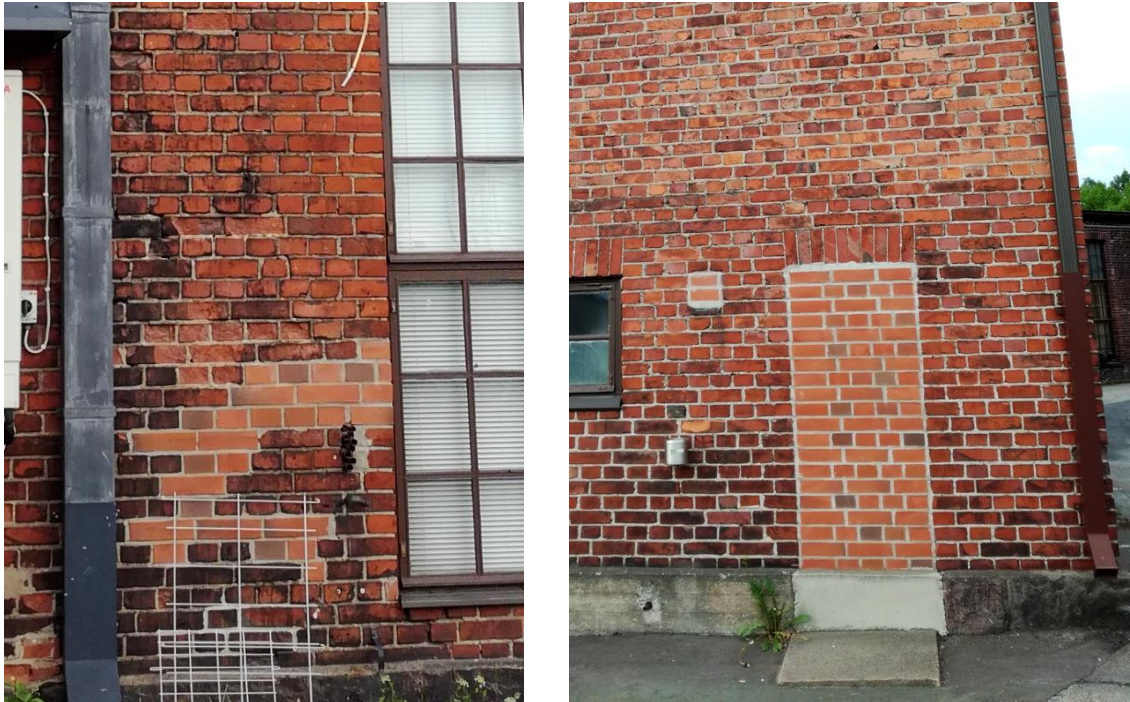
Kuva 16. Tiilien vaihtamisessa ei onnistu aina saada samanväristä lopputulosta, mutta teollisuusrakennuksen kohdalla julkisivun ulkonäköä tämä ei välttämättä haittaa. Kuva: E. Kangas, 06.2017.
