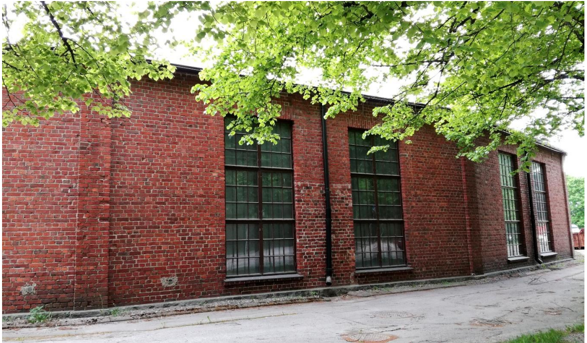
Kuva 27. Julkisivu Pohjoiselle asemakadulle. Kuva: E. Kangas, 06.2017.
