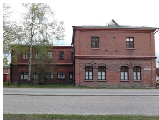
d) Julkisivu lounaaseen
