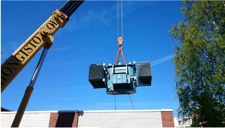
KUVA 27. Päämuuntajan nostaminen
