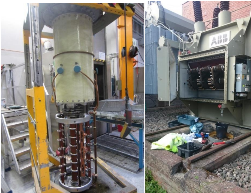
KUVA 21. Vasemmanpuoleinen käämikytkin sijaitsee muuntajan kannella muuntajan sisällä. Oikeanpuoleinen käämikytkin sijaitsee muuntajan sivussa. (7)
