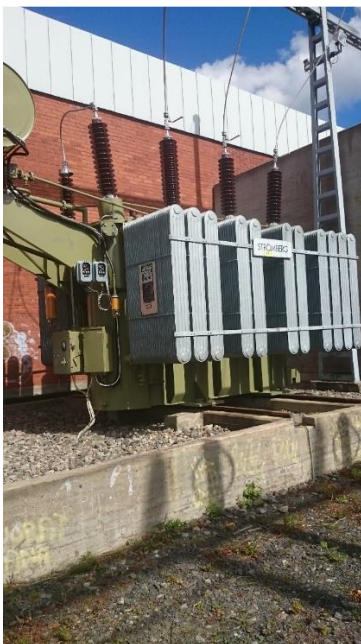
KUVA 1. Pateniemen sähköasemalla sijaitseva päämuuntaja
