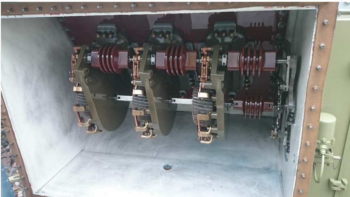
KUVA 23. Oulunsuunaseman PM1 käämikytkin
