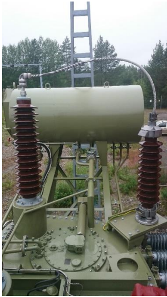
KUVA 18. Päämuuntajan 110 kV:n tähtipiste.
