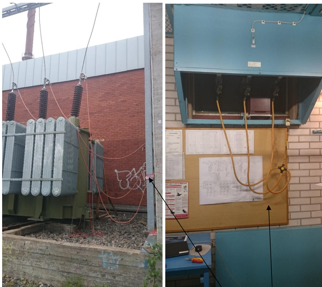
KUVA 26. Päämuuntajan työmaadoitus muuntajan ensiö- ja toisiopuolelta
