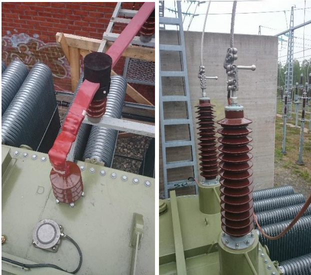
KUVA 17. Ensöpuolen sekä toisiopuolen läpiviennit
