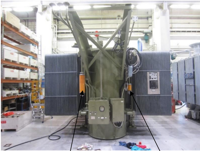
KUVA 14. Muuntajan sekä Käämikytkimen ilmankuivaimet (7)
