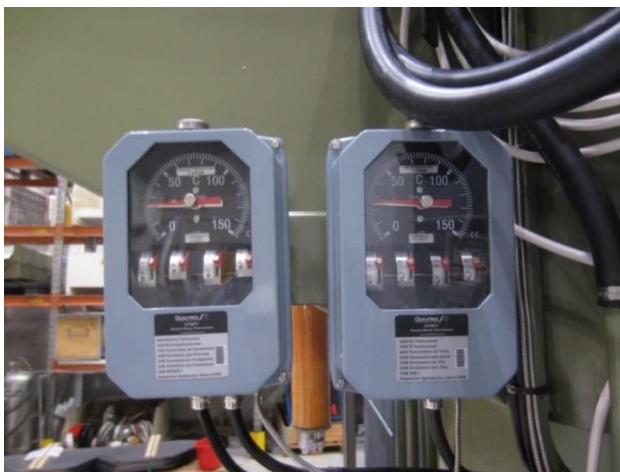
KUVA 13. Käämikytkeimen sekä muuntajaöljynlämpötilan mittaus. (7)
