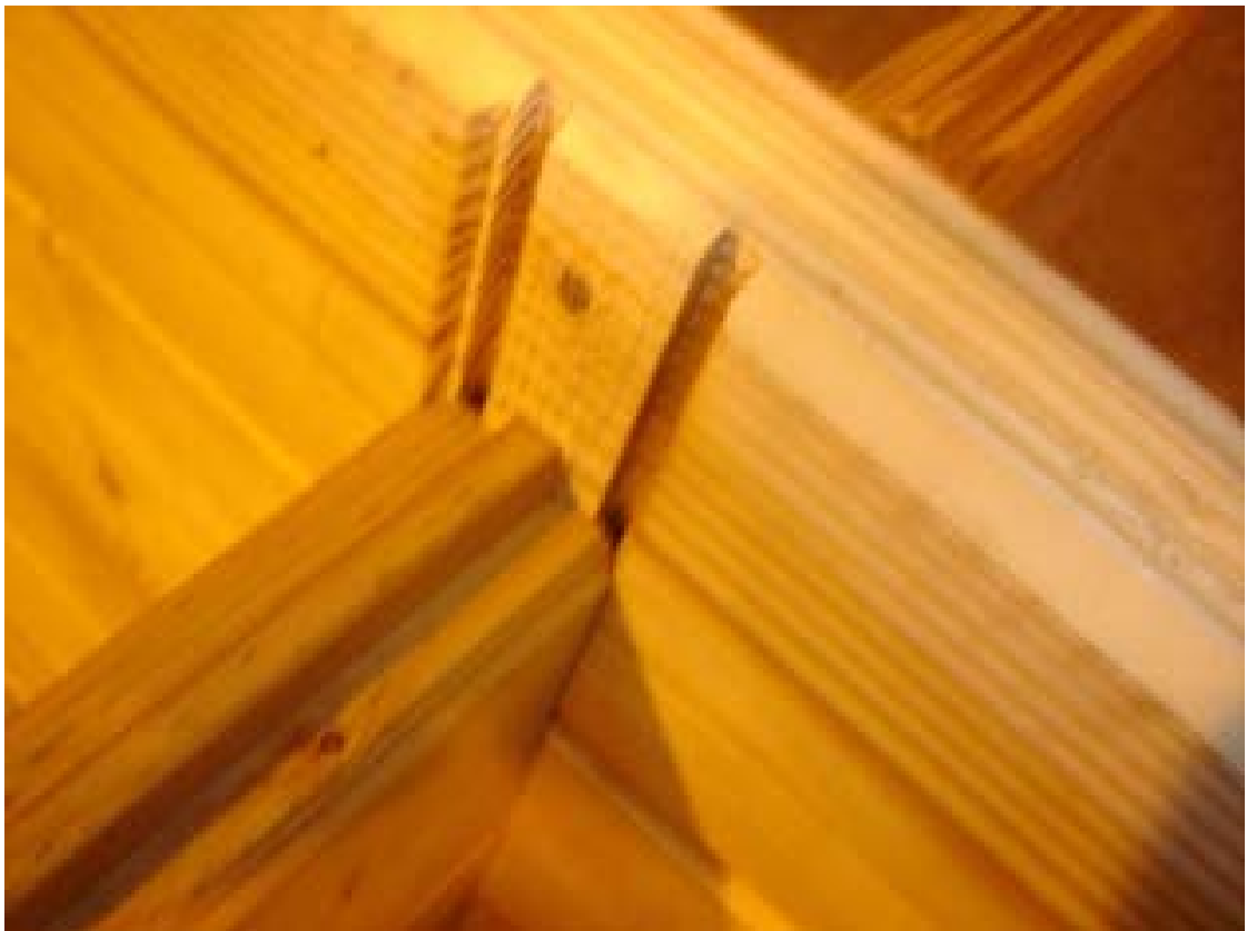
Kuva 8. Urissa esteetön vedenkulku.
