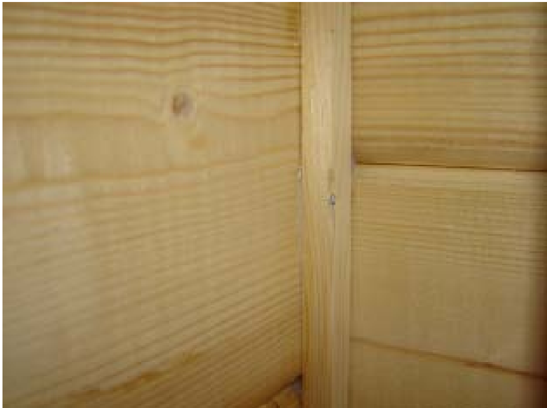
Kuva 12. Nauloilla kiinnitetty lista.
