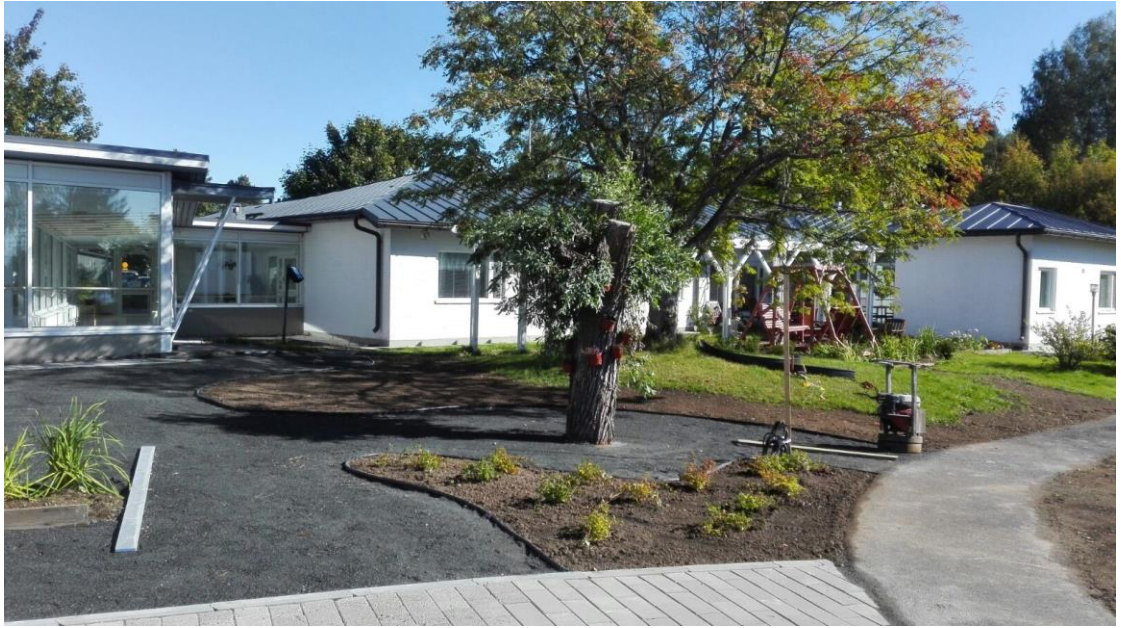
KUVA 1. Juvakodin piha rakennusvaiheessa (kuva: Marja-Liisa Paunonen)
