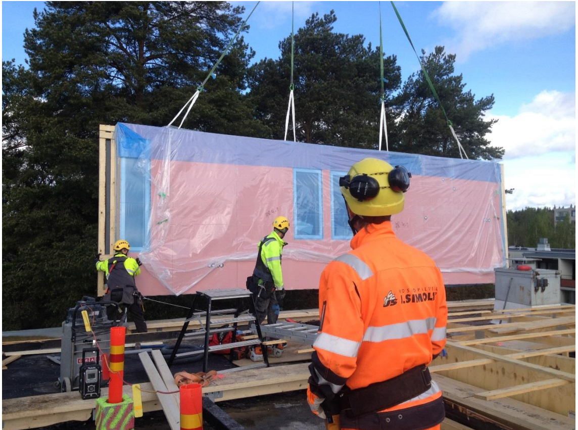
Kuva 4. As Oy Kuulaharjat; Ulkoseinäelementin asennus.
