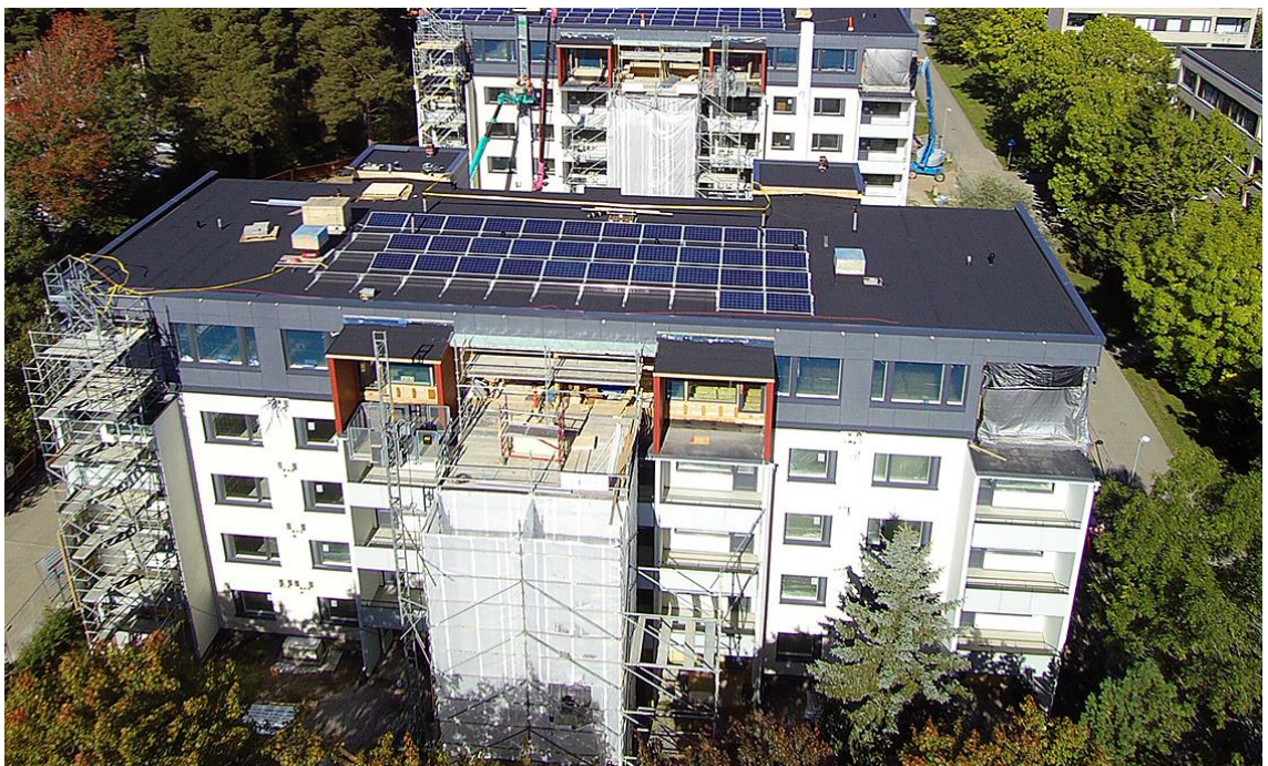
Kuva 5. As Oy Kuulaharjat; Työnaikainen kulkuteline katolle sekä roskakuilu.
