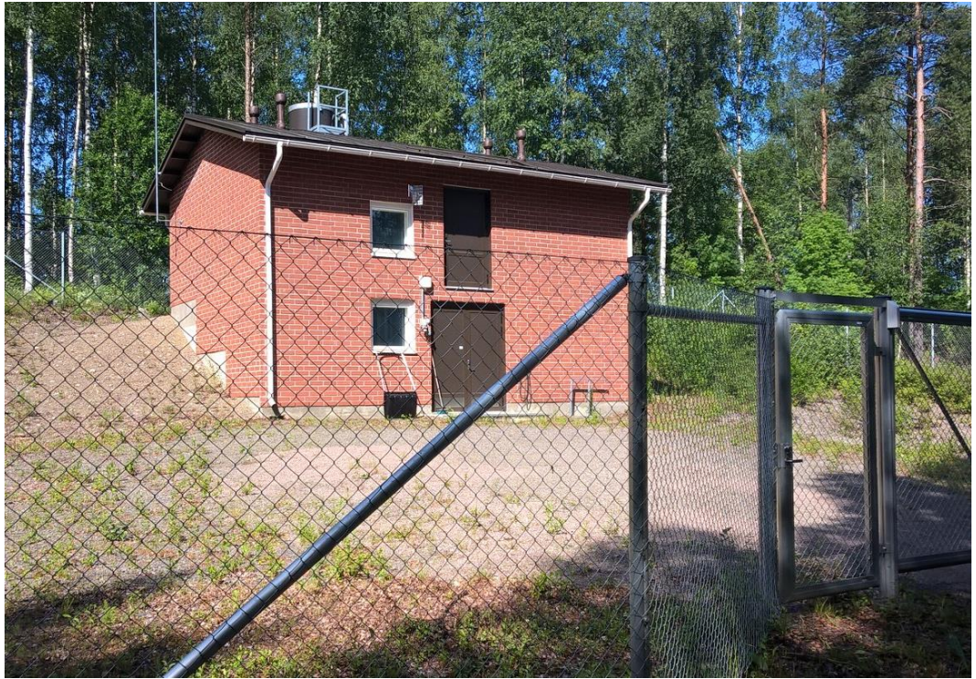
KUVA 2 Suojattu vedenottamo. Kulkua alueelle sääntelee rakennettu aitaus.
