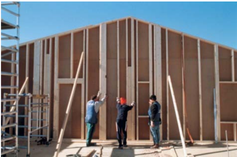
KUVIO 4. Seinän pystytystä käyttäen avointa puurakennusjärjestelmää. (Puuinfo 2007.)
