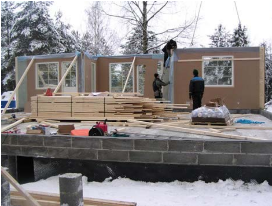
KUVIO 3. Suurelementtien asennusta. (Jetta-talo, [Viitattu 27.3.2010].)
