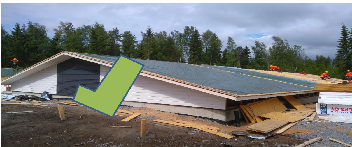
Kattoelementti on suojattu hyvin vesisateenvaralta.
