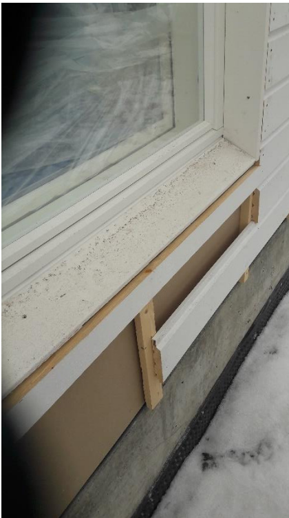
KUVA 7. Ikkunapellin tilalla lauta suojana
