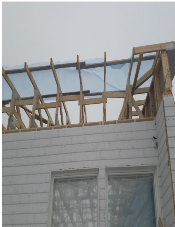
KUVA 8. Elementin yläosa on suojattu muovikaistaleella suoralta sateelta
