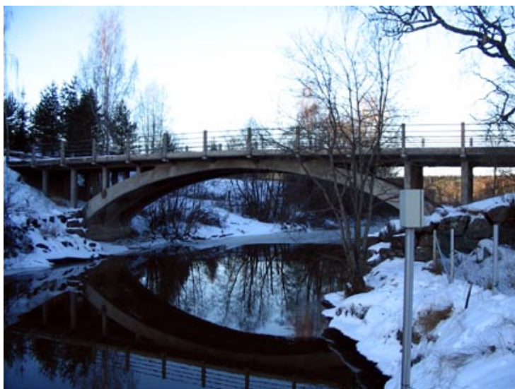
Kuva 1. Tönnönkosken silta ja myllypaikka, Orimattila. (Wager 2014.)
