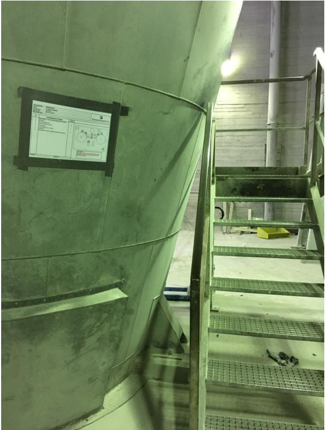
Kuva 3. Esimerkki tarkastuskierroksen työhöjeen sijoittelusta neljännen kerroksen alatasolle
