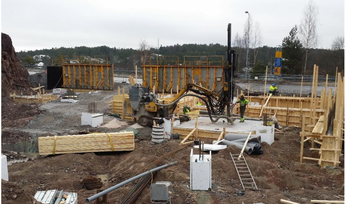
Kuva 2. Alapohjan täyttötöitä käynnistyneet.
