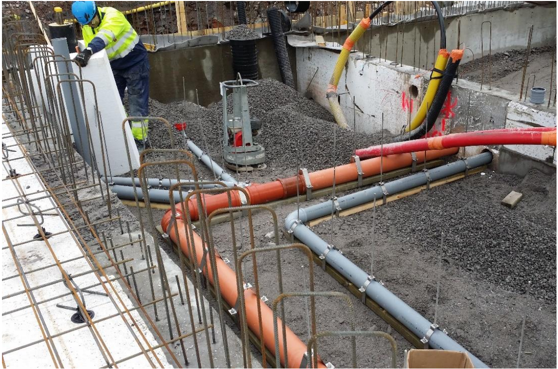
Kuva 4. Viemäri- ja täyttötöet käynnissä.
