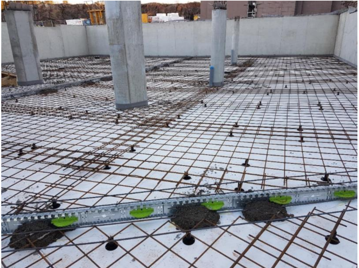
Kuva 5. Autohallin raudoitustarkastus.
