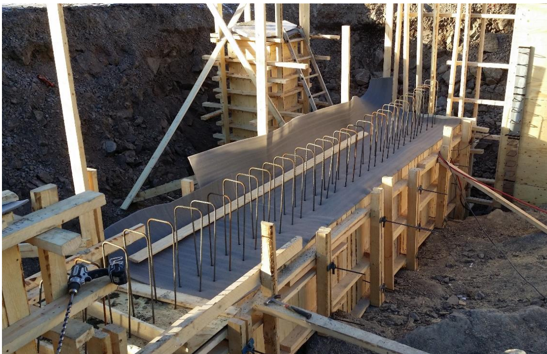
Kuva 1. Valettu ja suojattu kallionvarainen antura.
