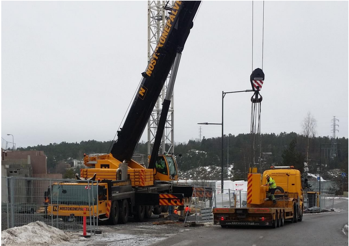
Kuva 6. Ajoneuvonosturin purkutyöt käynnissä.
