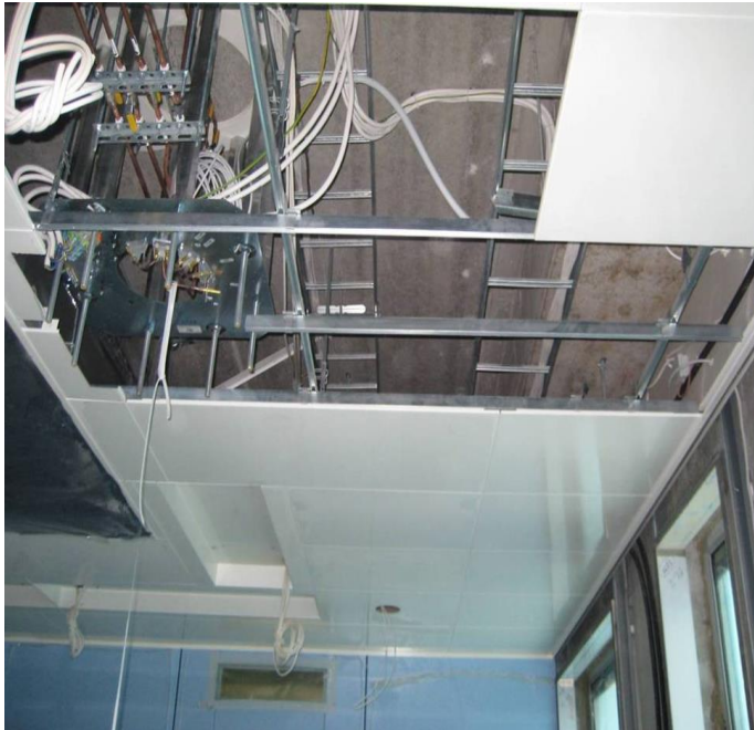
Kuvio 13. Tiivis ja avattava moduulikatto.
