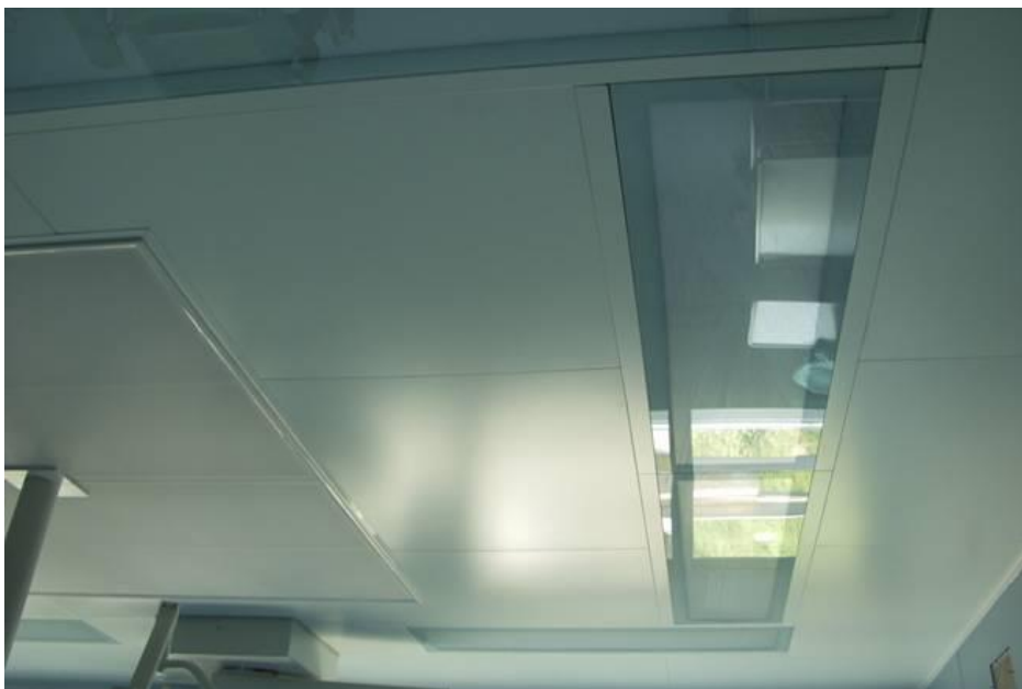
Kuvio 12. Tiivis moduulikattorakenne.
