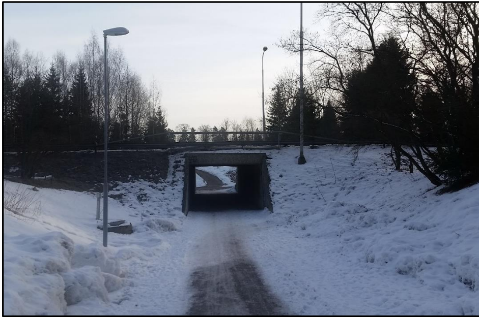
Kuva 27. Kaskitien alikulkutunnelin länsipuoli ennen toimenpiteitä talvella 2016.
