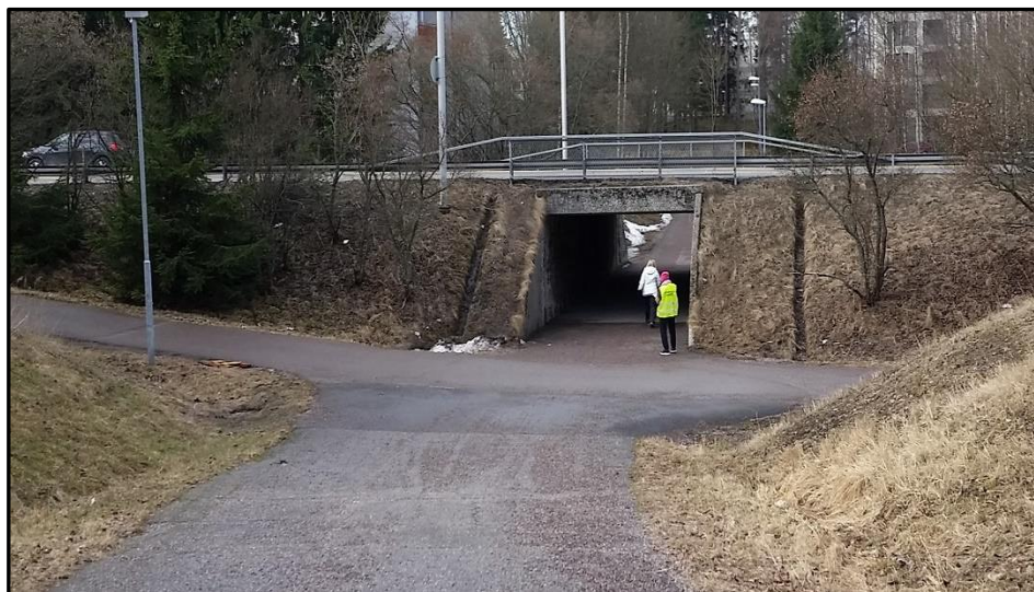
Kuva 26. Kaskitien alikulkutunnelin itäpuoli ennen turvallisuustoimenpiteitä 4/2016.
