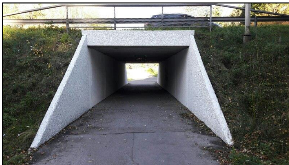
Kuva 31. Kaskitien alikulkutunnelin sisäseinät ja tunnelin suut valkoisiksi maalattuina.
