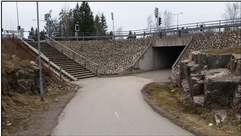
Kuva 21. Sipoontien alikulkutunnelin itäpuoli ennen turvallisuustoimenpiteitä 4/2016.
