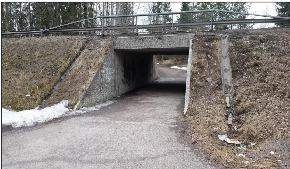
Kuva 38. Punajuurikujan alikulkutunnelin itäpuolen suuaukko ennen toimenpiteitä 4/2016.
