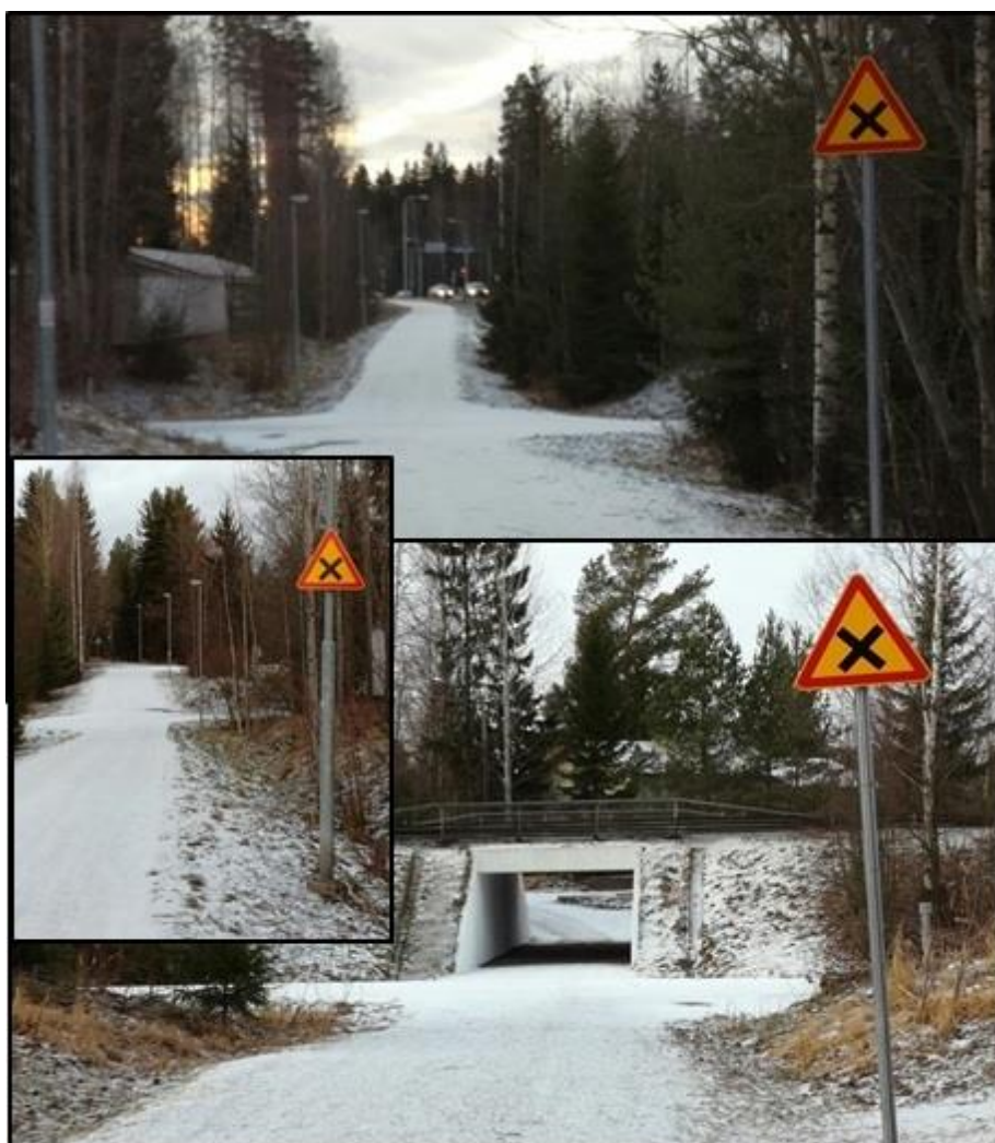
Kuva 44. Punajuurikujan uudet liikennemerkit alikulun itäpuolella.
