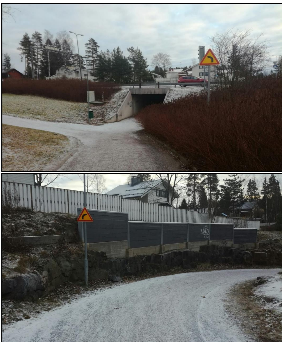
Kuva 23. Sipoontielle asennetut kaartuvien väylien varoituskolmiot molemmin puolin tunnelia.
