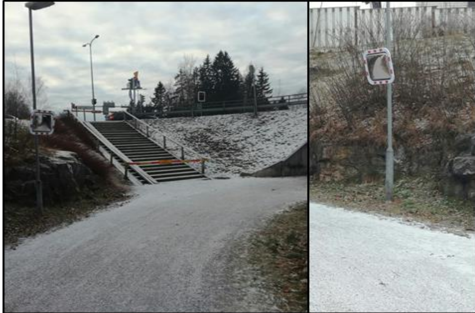
Kuva 24. Sipoontien tunnelin itäiselle suulle asennettu peili kuvattuna molemmista tulosuunnista.
