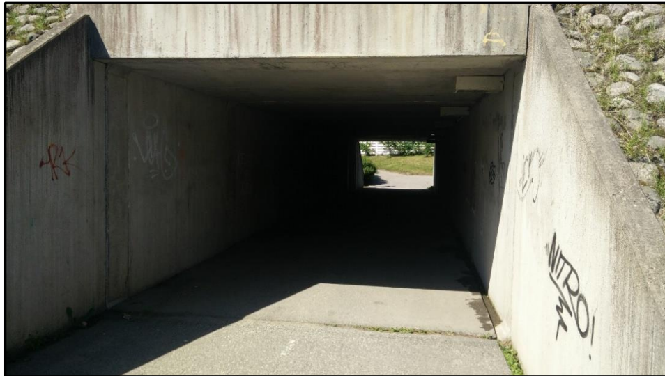
Kuva 47. Sipoontien tunnelin pimeys päivällä kesäisessä kirkaassa säässä.
