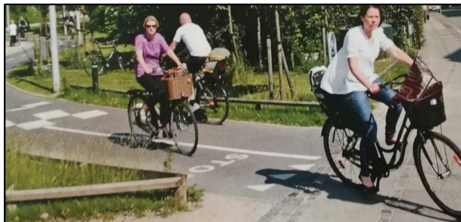
Kuva 56. Esimerkki, jossa kaksisuuntainen pyörätie liittyy sekaliikenneväylään. Huomaa hidastetyövyys ja väylään maalatut stop-merkintä sekä varoituskolmiot (Verne, TTY. Parhaat Eurooppalaiset käytännöt pyöräilyn ja kävelyn edistämiseksi, 2011).
