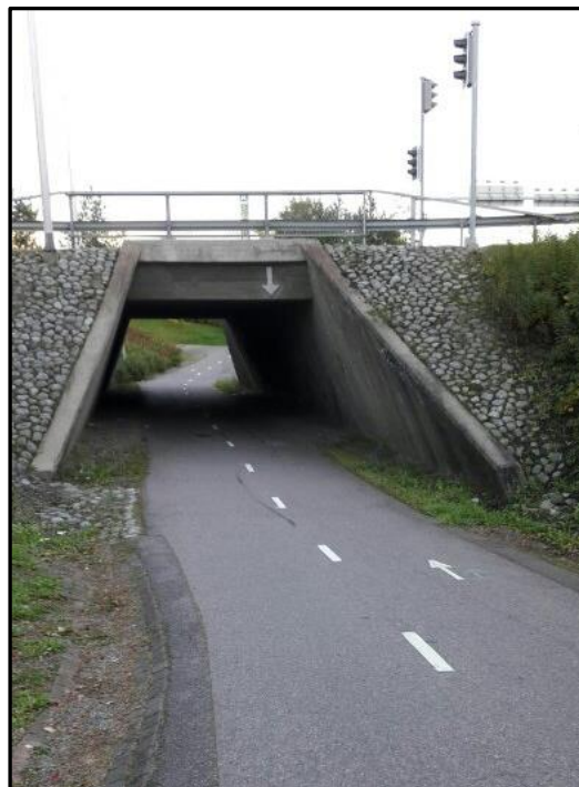
Kuva 36. Laurilantien vahvistettu keskilinjan viivoitus sekä kulkusuuntaa indikoivat nuolet tunnelin suun yläpalkissa ja väylän pinnassa.
