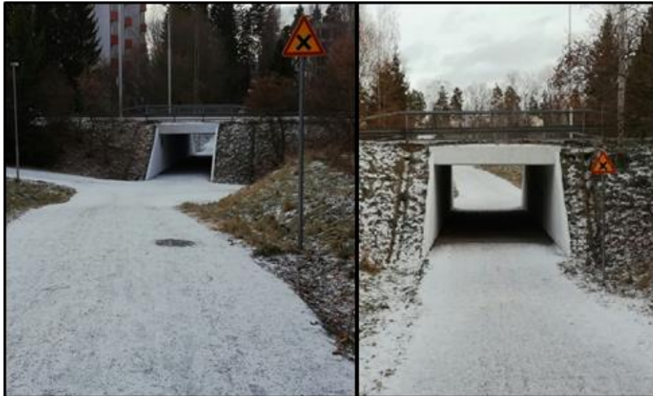
Kuva 29. Kaskitielle asennetut lähestyvän risteuksen varoituskolmiot itä-länsisuunnassa.
