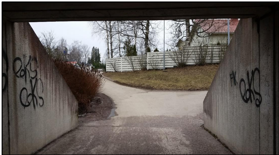
Kuva 22. Sipoontien alikulkutunnelin länsipuolen suunäkymä 4/2016.
