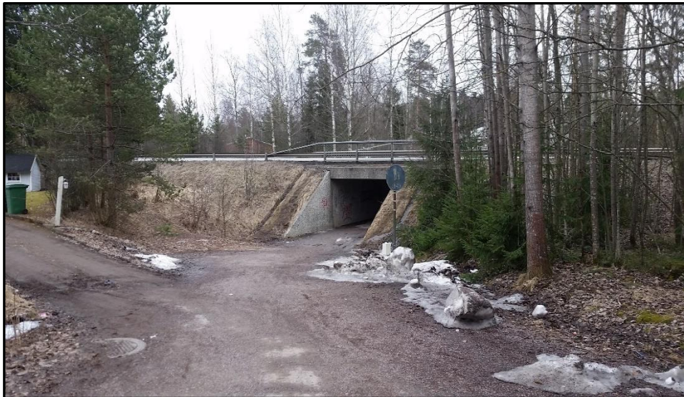
Kuva 39. Punajuurikujan alikulkutunnelin länsipuoli ennen turvallisuustoimenpiteitä 4/2016.
