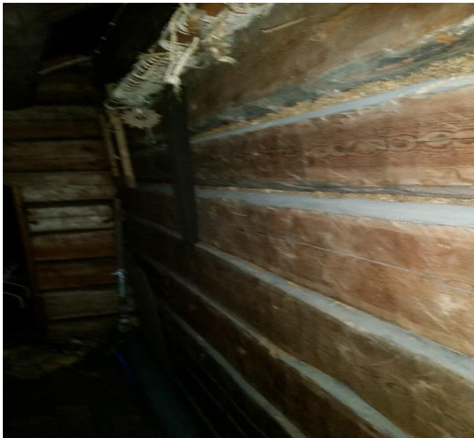
Kuva 17. Kartanon hirsiseinän avovaraus. Tilkkeenä on käytetty turvetta ja sahanpurua.
