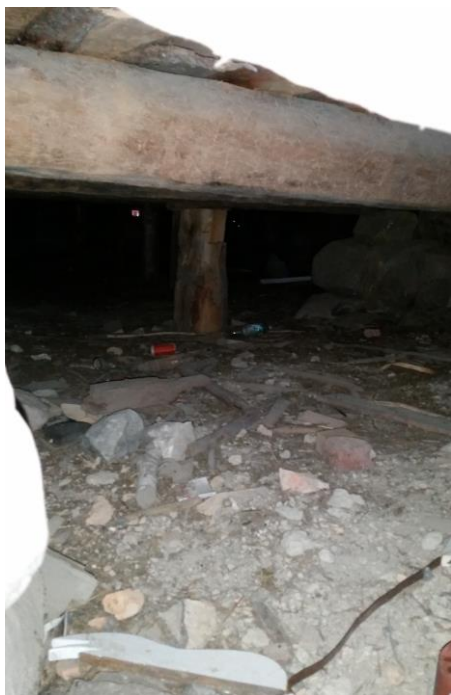
Kuva 4. Hirsiseiniä on tuettu hirsipölkyillä ja päällekkäin ladotuilla kivillä
