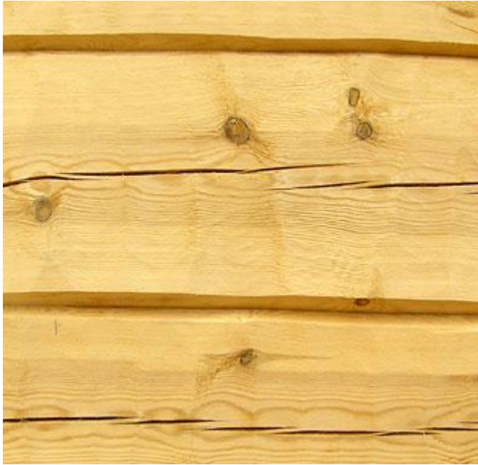
Kuva 16. Hirsiseinän umpivaraus [13].
