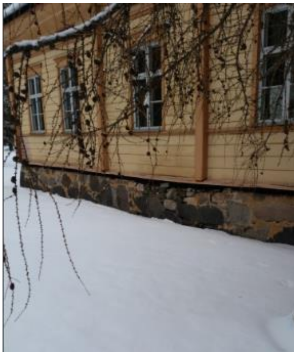
Kuva 7. Kartanorakennuksen kivijalka.
