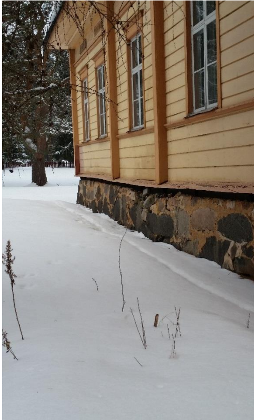
Kuva 19. Kartanon alimman hirren painuminen on aiheuttanut seinän roikkumisen.
