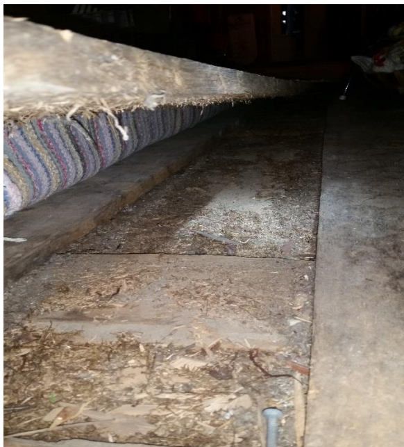
Kuva 20. Kartanon välipohjan eristeinä on turvetta, hiekkaa ja sahanpurua.
