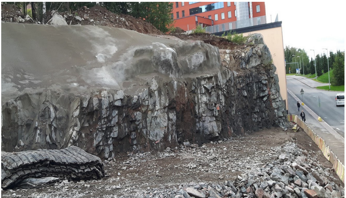
Kuva 8. Pysyväksi jäävän maaluisen eroosiosuojauksen ruiskubetonoimalla
