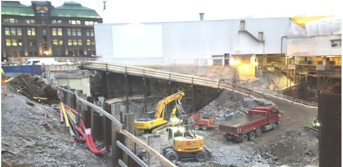
Kuva 10. Ahtaan työmaan ajoluiska toteutettuna teräksisenä siltarakenteena
