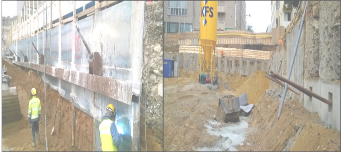
Kuva 3. Teräksinen settiseinä sekä kaivnopaalujen ja suihkupaalujen yhdistelmä (KFS Finland Oy 2017)
