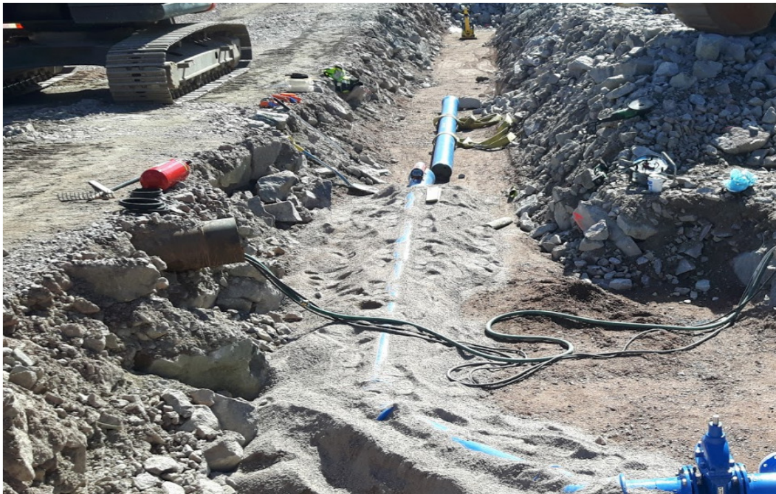
Kuva 11. Putkikaivannon työalueen läpi kulkevien johtojen suojaus teräsputkella
