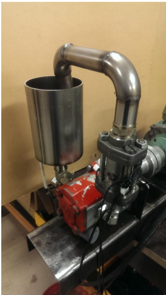
Kuva 5. Mittauksissa käytettävä hydraulikkajärjestelmä koostuu öljysäiliöstä, putkistosta, hammasrataspumpusta sekä pumppua pyörittävästä sähkömoottorista ja mittausputkesta.
