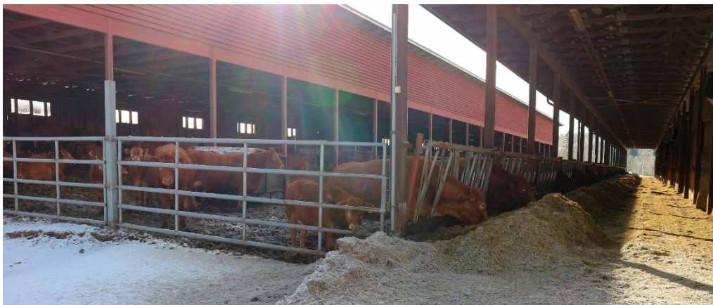
Kolmiseinäinen katos emolehmien kasvatusrakennuksena.
