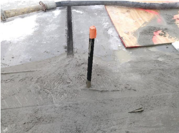
Kuva 18. Delta-palkin mittaputki asennettiin valun yhteydessä
