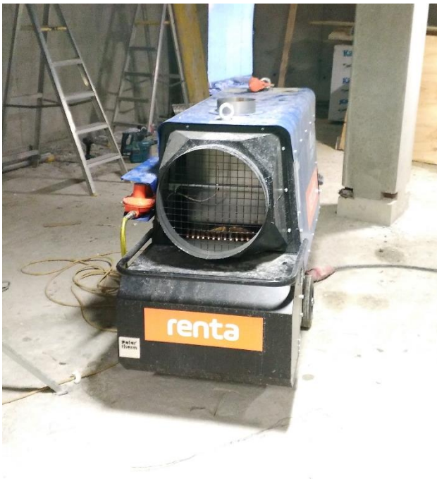
Kuva 16. Kaukolämpöverkkoon liitetty puhallin
