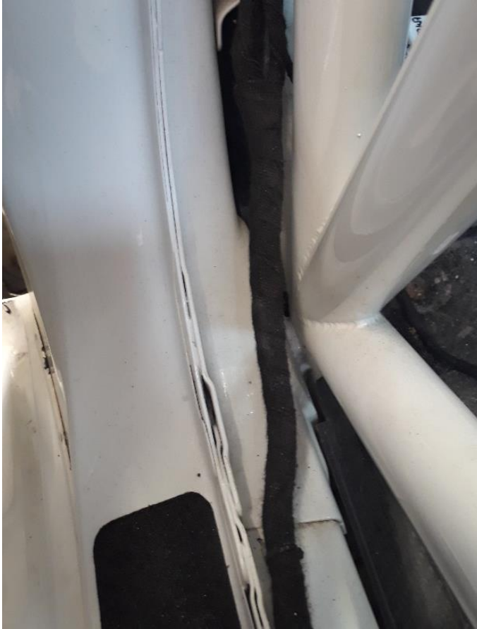
Kuva 9. Kuvassa johtimet kulkevat sääntöjen vastaisesti korirakenteen ja turvakehikon välissä
