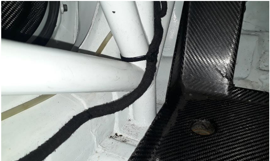
Kuva 8. Kuvassa johtosarja kulkee oikein turvakehikon sisäpuolella
