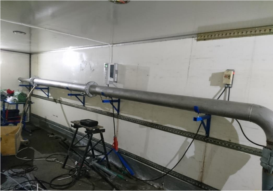
KUVA 9. Konttiin rakennettu laboratorio
