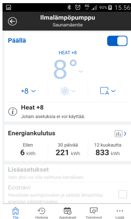
Kuva 10. Ilmalämpöpumpun asetusten näyttö
