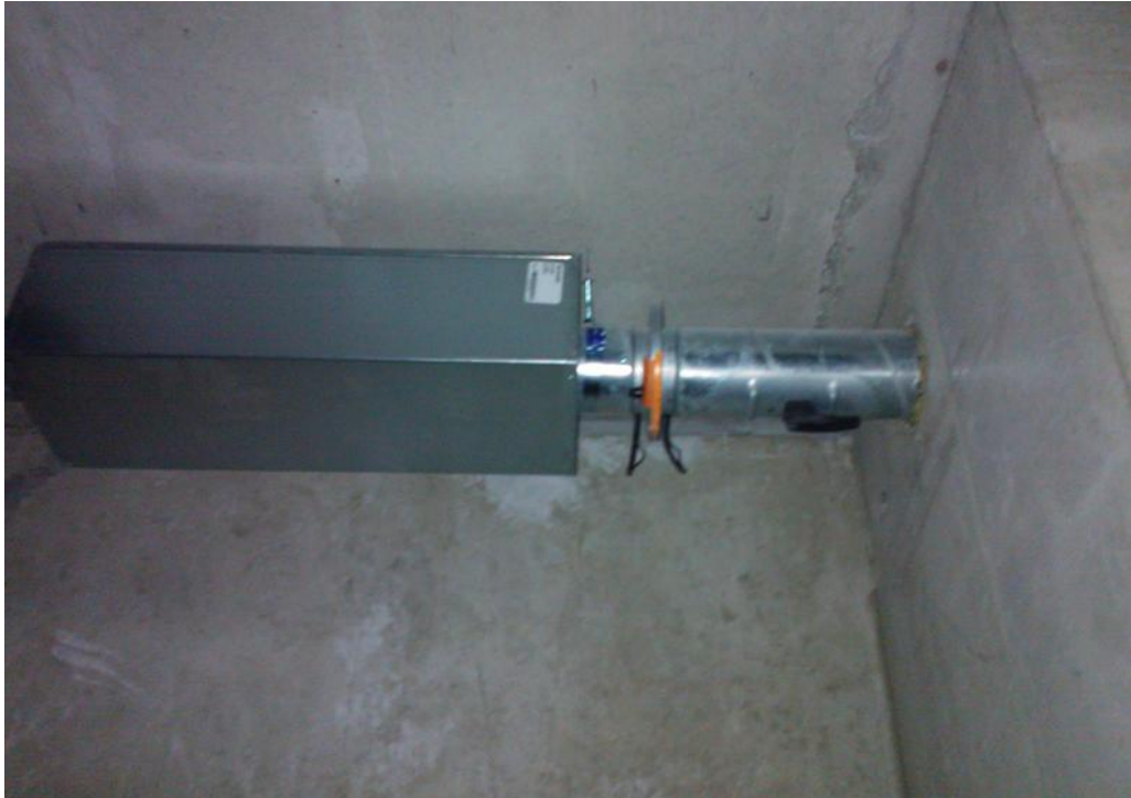
Kuva 7. Kahvalla varustettu puhdistusluukku asennettuna äänenvaimentimen ja säätöpellin oikealle puolelle ennen elementtihormin liitosta.
