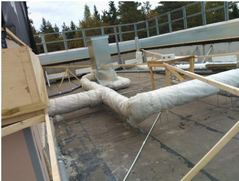
Kuva 6. Eristettyjä runkokanavia vesikaton eristetilassa ennen peittävän eristekerroksen asennusta.
